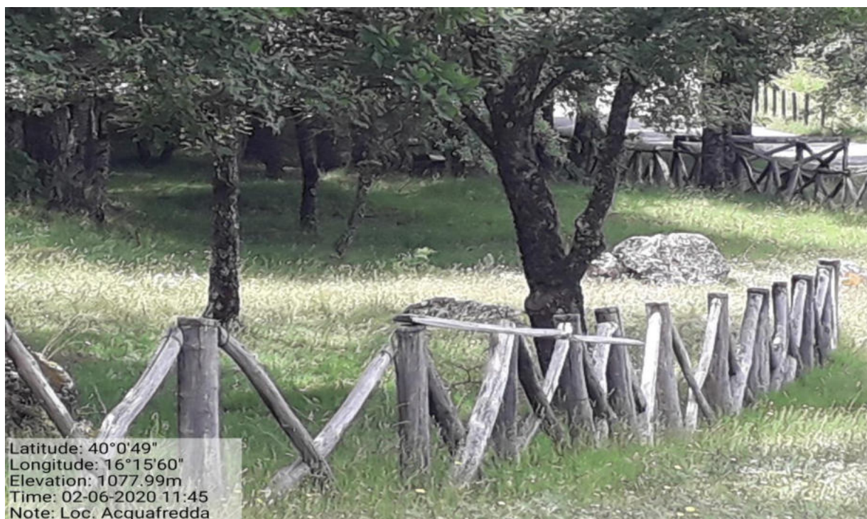
Int. 8.1.1_ –Manutenzione Staccionate. Loc. Acquafredda.
