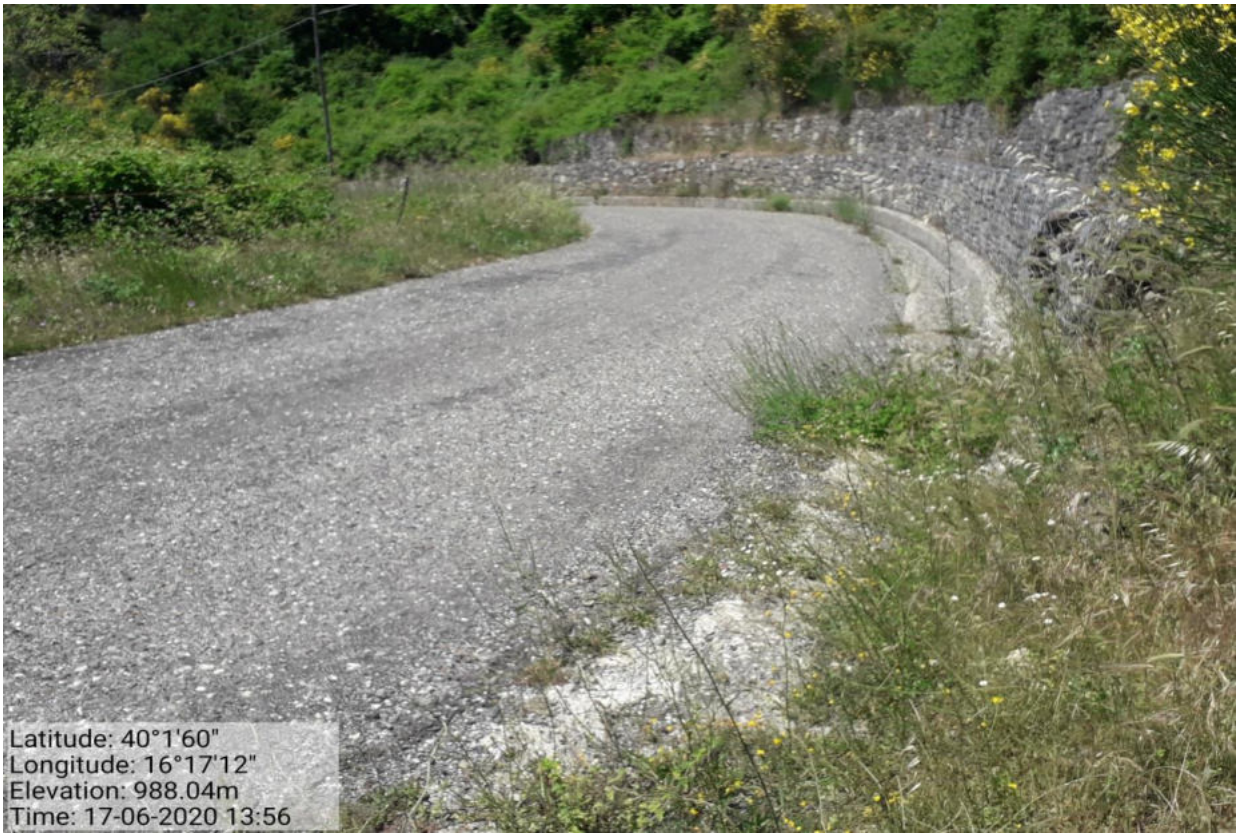
Int. 5.1.4_5.2.4 –Manutenzione Strade Loc. Martorino.
