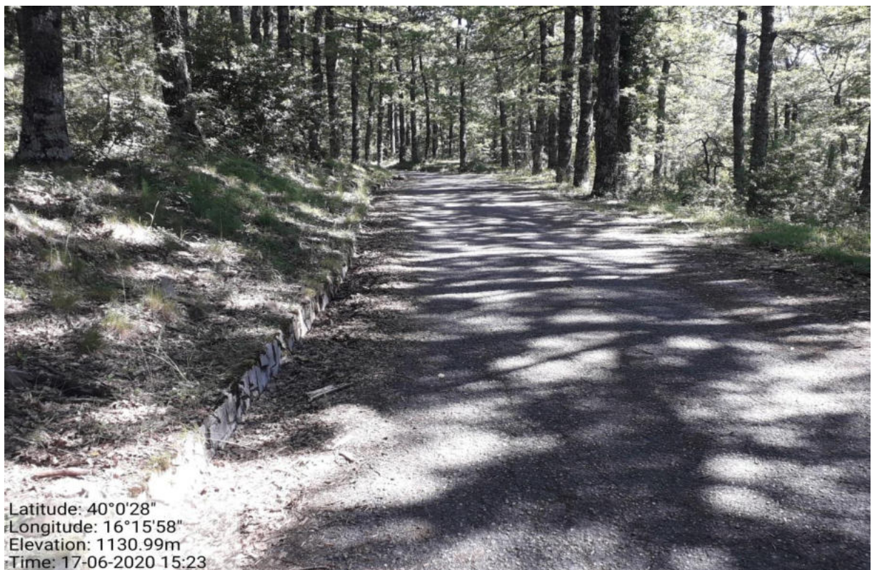
Int. 5.1.6_5.2.6 –Manutenzione Strade Loc. Innesto Provinciale – Pietrasasso.
