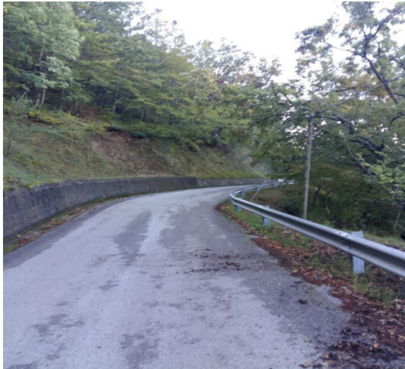
Int. Manutenzione Loc. Ischitelle
