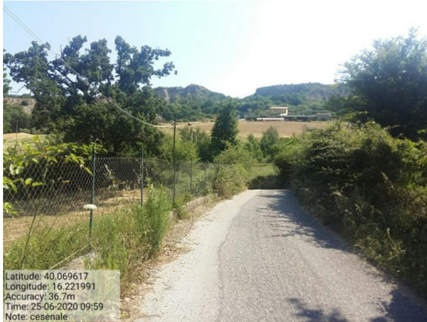
Int .Pulizia cunette e scarpate Loc. Cesenale
