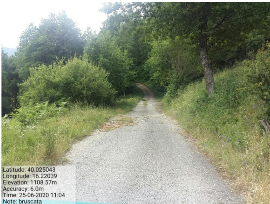
Int. Pulizia cunette e scarpate Loc. Bruscata
