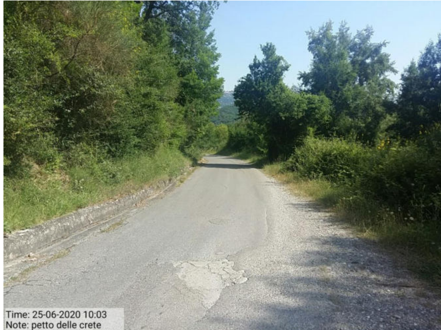
Int .Pulizia cunette e scarpate Loc. Petto delle Crete
