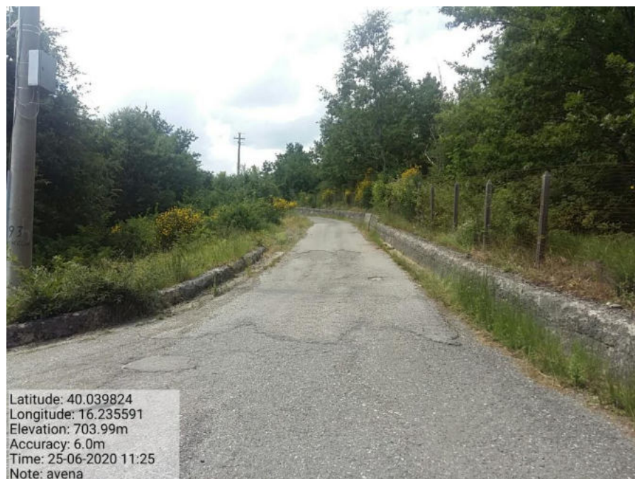
Int. Manutenzione pista forestale LOC. Avena
