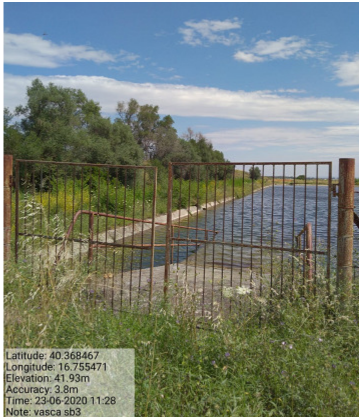
Int.4.1.10 Vasca Sb3 Manutenzione area recintata
