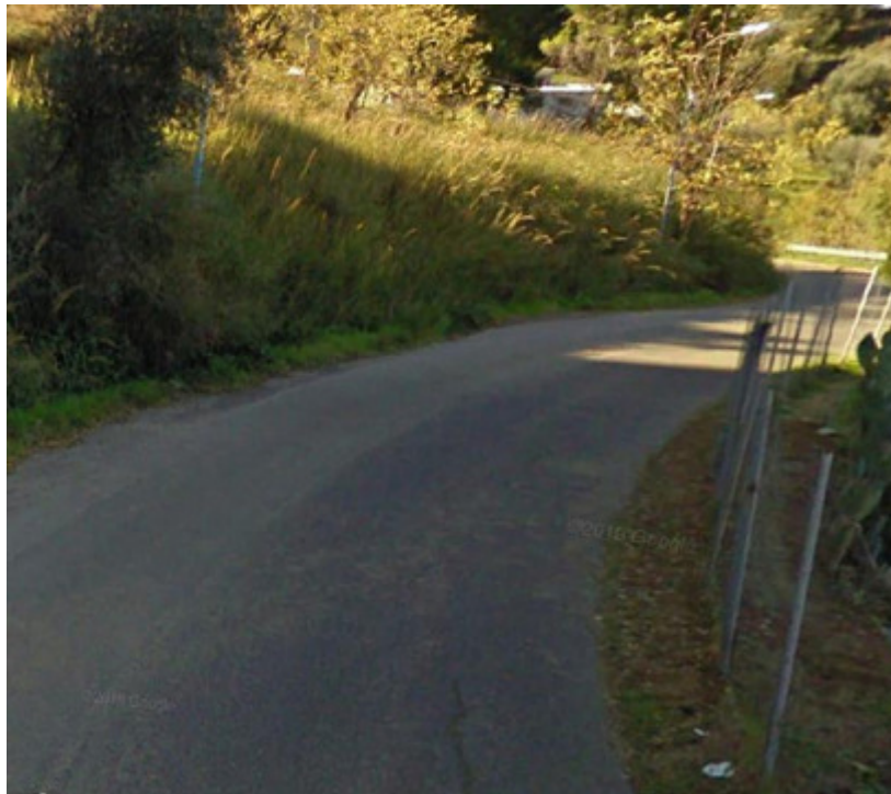
Int.5.1.1 S.P. 18 Pisticci-Pozzitello Manutenzione della Viabilità
