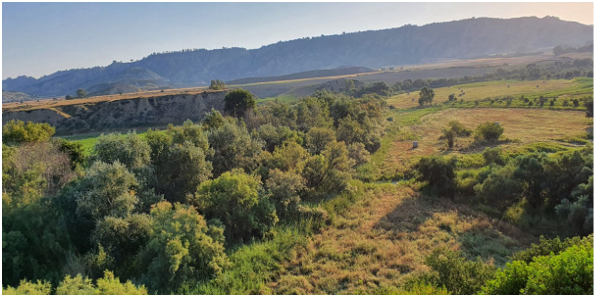
Int.6.1.1 Argine dx fiume Cavone
