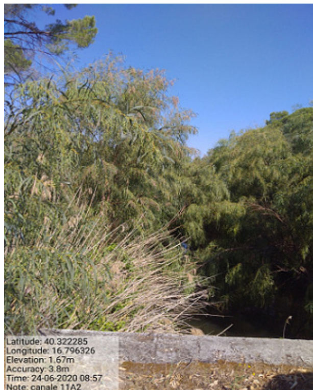
Int.4.1.3 Loc. Canale11/A2 Manutenzione asta fluviale
