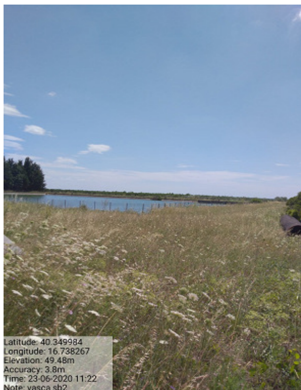
Int.4.1.9 Vasca Sb2 Manutenzione area recintata
