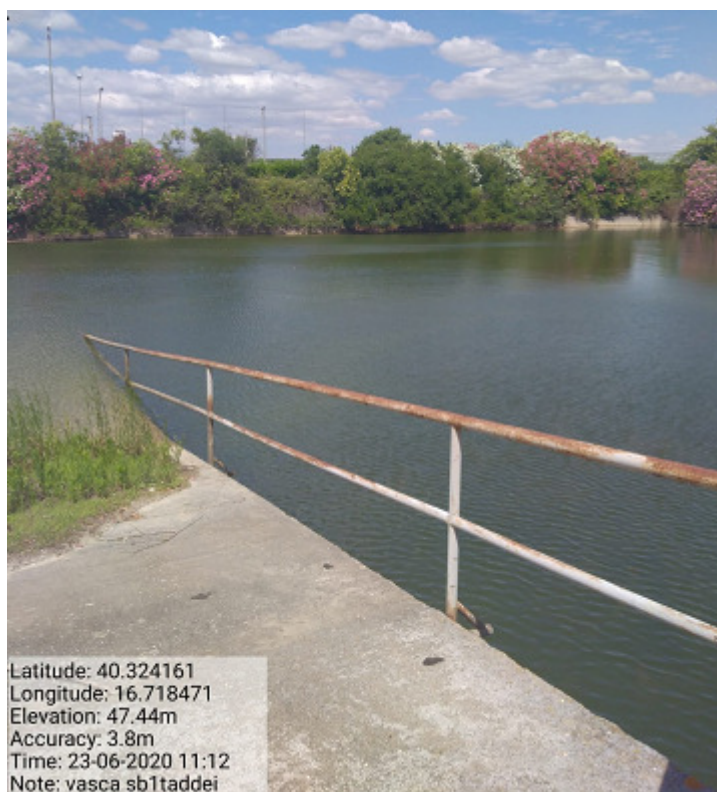
Int.4.1.7 Vasca Sb1 Taddei Manutenzione area recintata
