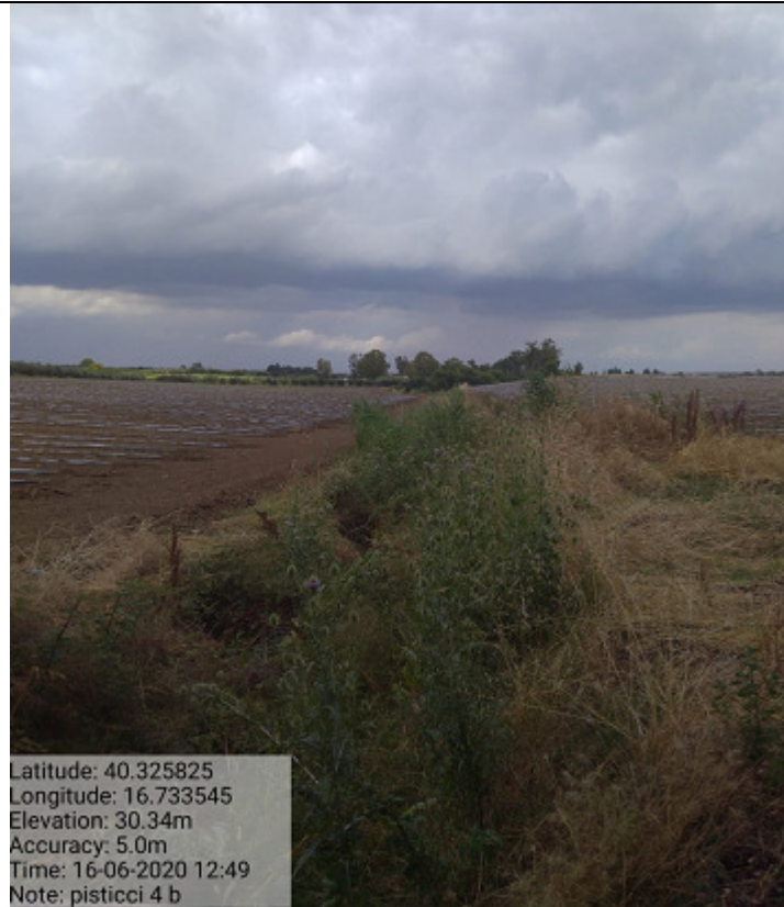
Int.4.1.2 Loc. Canale4/A11 Manutenzione asta fluviale
