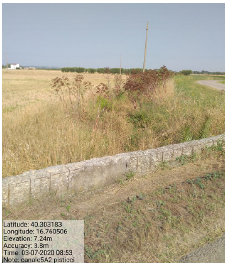
Int.4.1.6 Loc. Canale5/A2 Manutenzione asta fluviale
