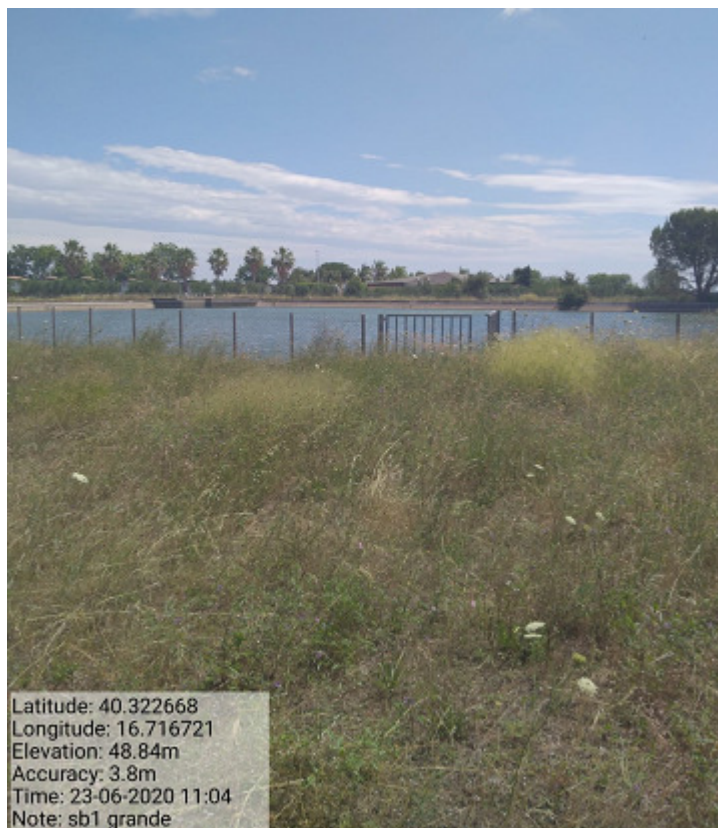
Int.4.1.8 Vasca Sb1 Manutenzione area recintata
