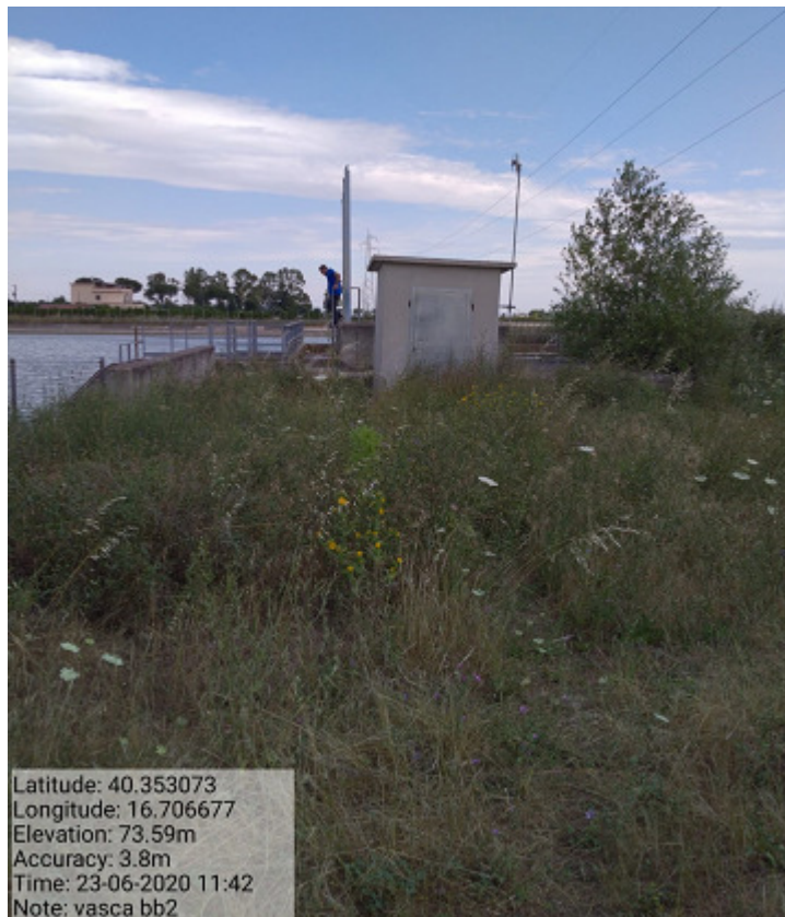
Int.4.1.11 Vasca Sb32 piccola Manutenzione area recintata
