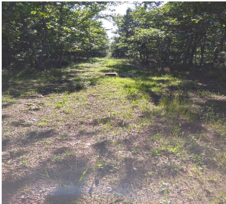
Int.1.1.1 Loc. La Dispensa- Ferrandina; manutenzione VIALE TAGLIAFUOCO Coordinate geo. 40.546341N 16.375484E
