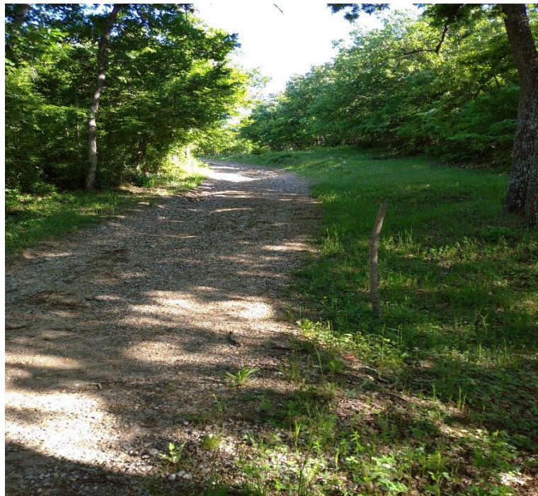
Int. 3.1.1 Loc. La Dispensa , Fonnoni, San Nicola - Ferrandina ; MANUTENZIONE DI PISTA FORESTALE Coordinate geo. 40.546361N 16.378774E
