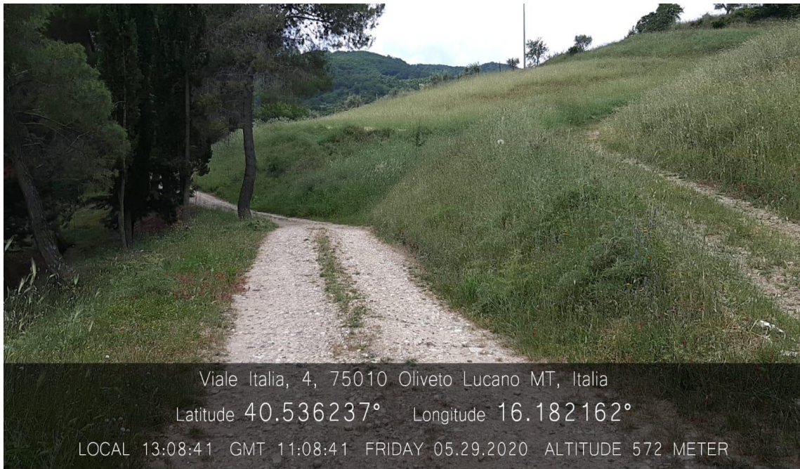
Int. 3.2.2 Loc. Mezzane(via Italia) – Oliveto Lucano ; MANUTENZIONE DI PISTA FORESTALE Coordinate geo. 40.536237N 16.182162E
