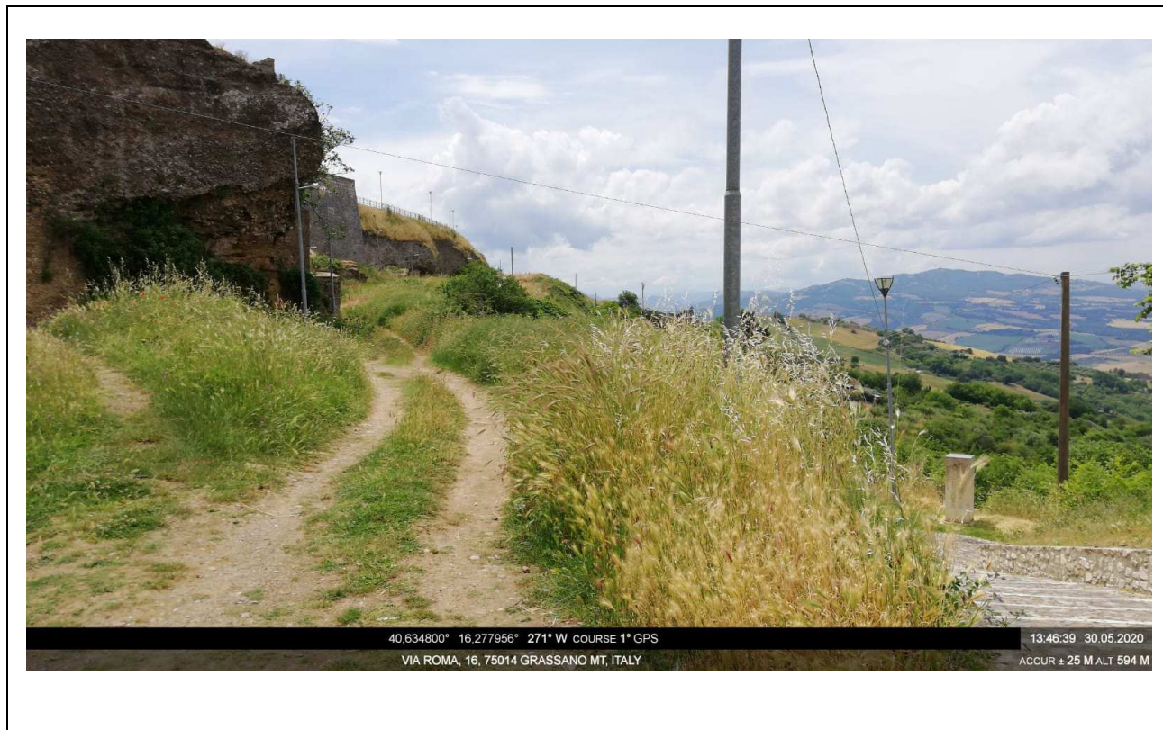
Intervento 1.2.3 LOC : Grassano Fg,12 P.103-1302
