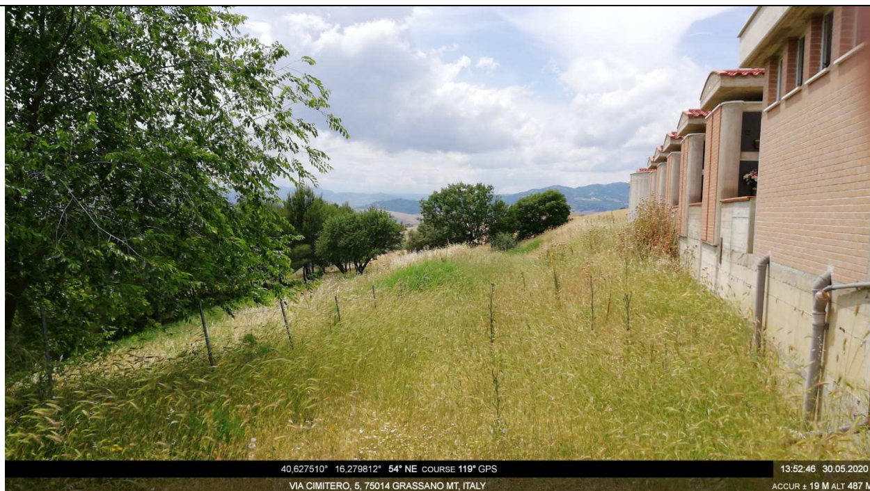
Intervento 1.2.1 LOC : Grassano PERIMETRO CIMITERO F.15 P.441-A-598
