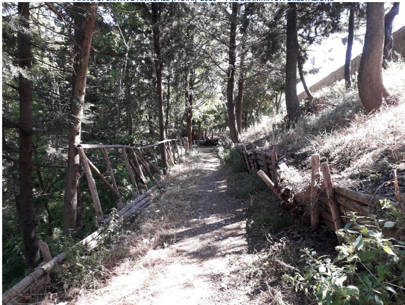
COMUNE DI MIGLIONICO - REALIZZAZIONE DI UNA STACCIONATA SOTTO IL CASTELLO
