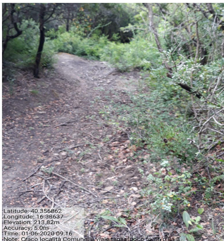
Int.1.1.2 Loc. Comunella fg.35 p.lla 3 Manutenzione viale tagliafuoco
