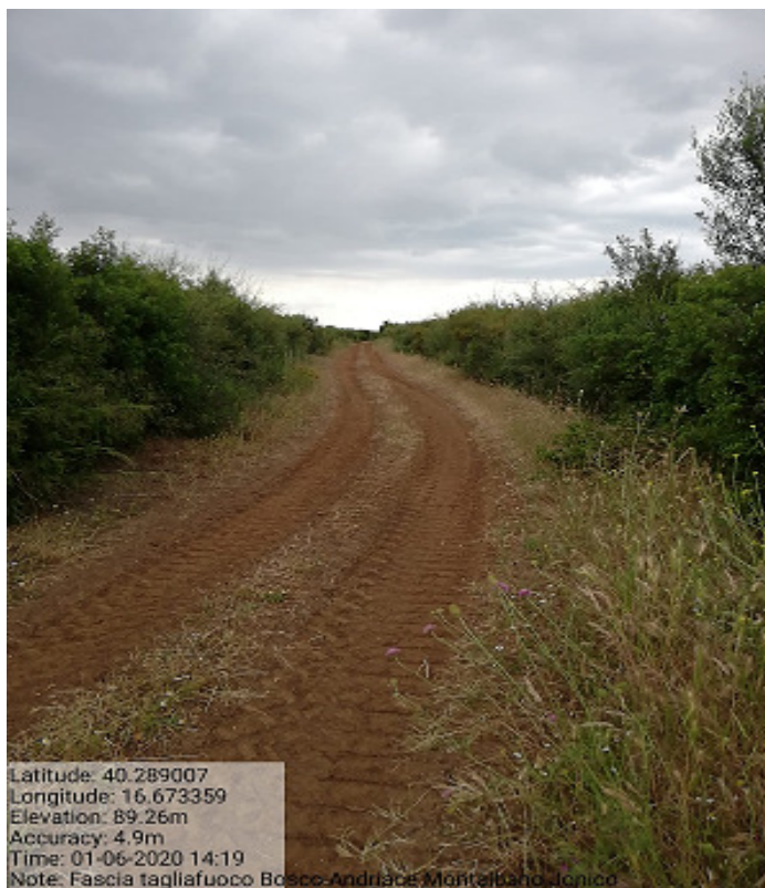
Int.1.1.3 Loc. Bosco Andriace fg.63 p.lla 45 Manutenzione viale tagliafuoco
