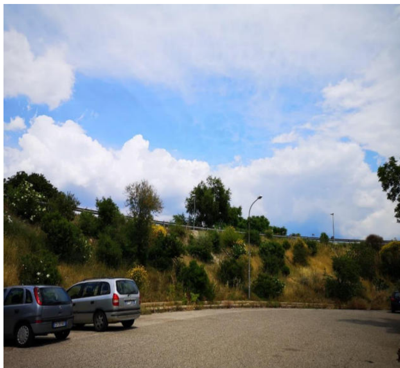
Int. 1.1.4 Loc. Hotel 407 – scalo Garaguso; DECESPUGLIAMENTO DEL TERRENO Coordinate geo. 40.5931760N 16.2459190E
