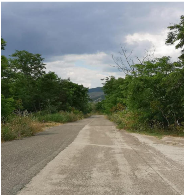
Int.5. 1.1 /5.2.1 Loc.Scalo di Garaguso; DECESPUGLIAMENTO E PULIZIA CUNETTE DI STRADA COMUNALE Coordinate geo. 40.595183N 16.236921E
