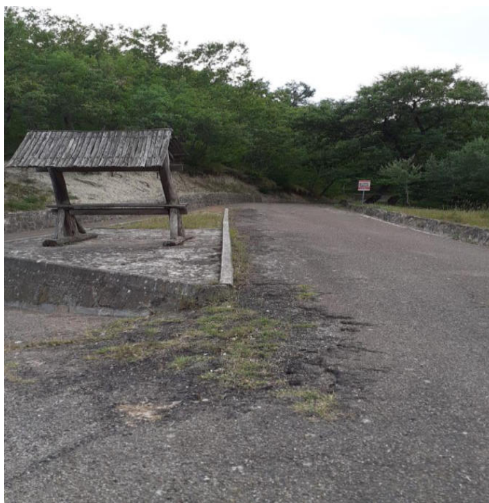
Int.5. 1.2/5.2.2 Loc.Riciglio/Cesine; DECESPUGLIAMENTO E PULIZIA CUNETTE DI STRADA COMUNALE Coordinate geo. 40.546585N 16.213751E
