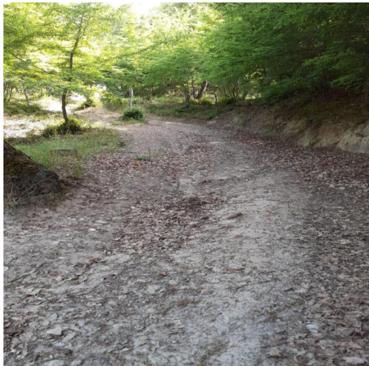
Int. 3.1.1 Loc.Riciglio/Cesine – Garaguso; MANUTENZIONE DI STRADA FORESTALE Coordinate geo. 40.5454880N 16.2140020E
