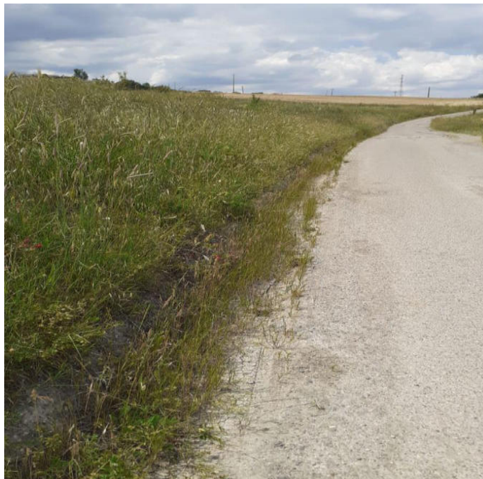
Int.5.1.4/5.2.4 Loc.Serre Campo sportivo; DECESPUGLIAMENTO E PULIZIA CUNETTE DI STRADA COMUNALE Coordinate geo. 40.559247N 16.228539E
