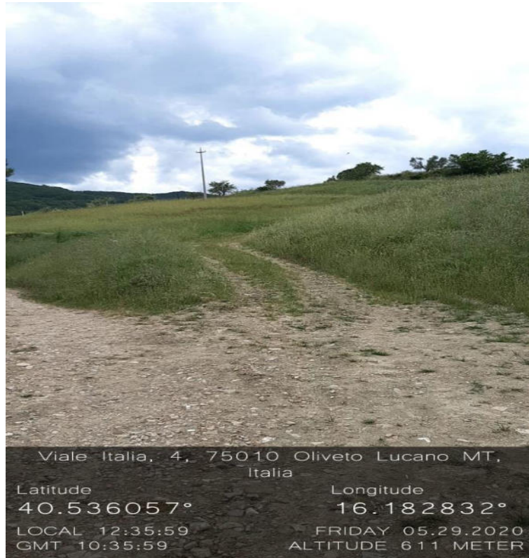
Int. 3.2.1 Loc.Destre (via Italia) – Oliveto Lucano; MANUTENZIONE DI PISTA FORESTALE Coordinate geo. 40.536057N 16.182832E
