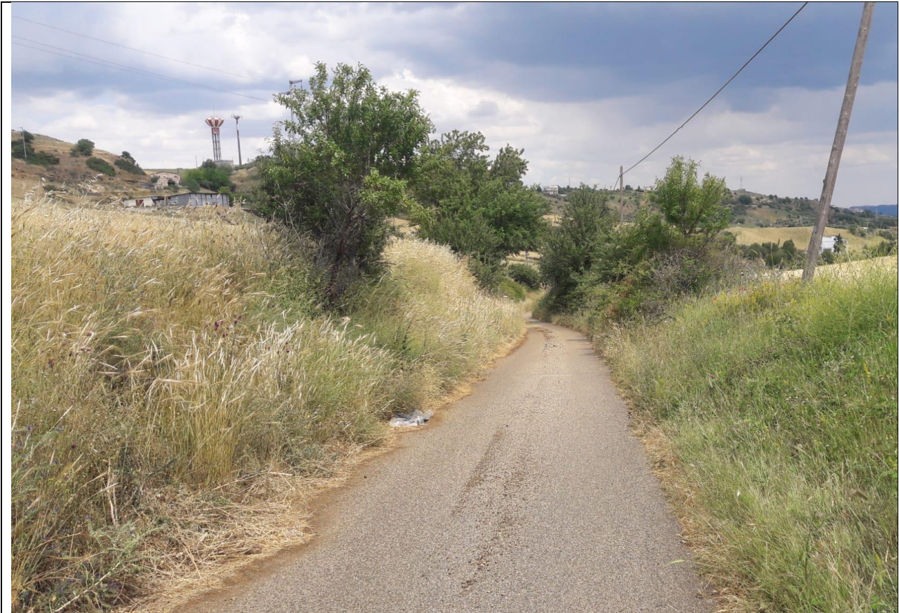
Intervento 5.1.2 Loc. Grottole Str. Comunale Fontana di Lupo Lat. 40.604961 Lon. 16.359554
