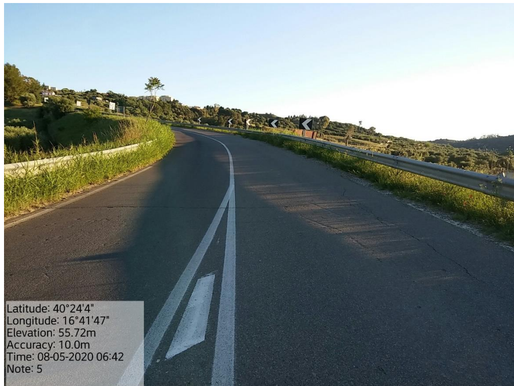
Int. 5.1.1 Loc. Bernalda - S.P. Carrera (Bernalda-bivio S.S. 407 Basentana)- Decespugliamento Scarpate stradali
