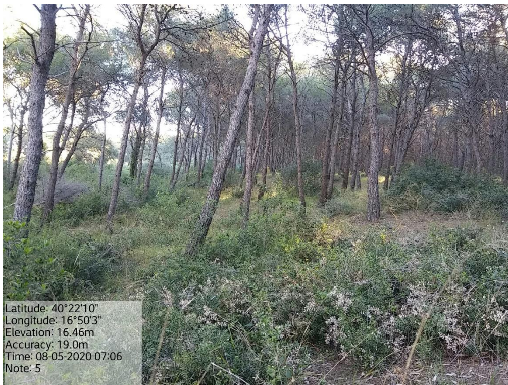
Int. 1.1.3 Loc. Santa Palagina – Manutenzione di viale tagliafuoco
