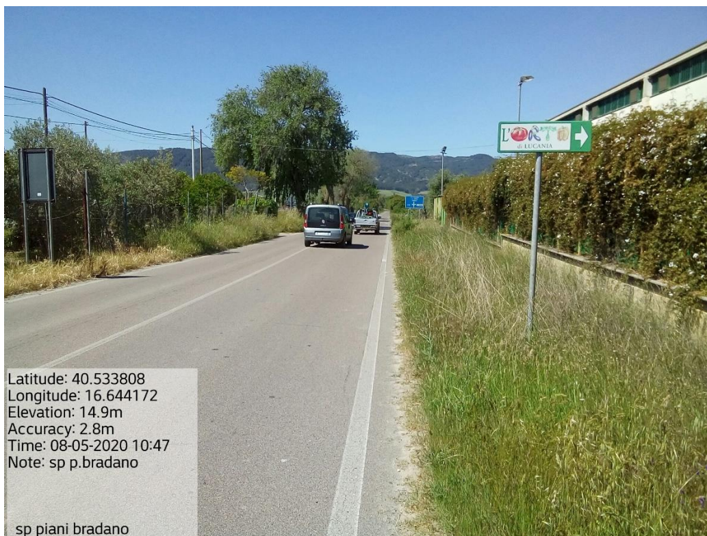
Int. 5.1.1 Loc. S.P. 33 Montescaglioso – Piani Bradano - Decespugliamento Scarpate stradali
