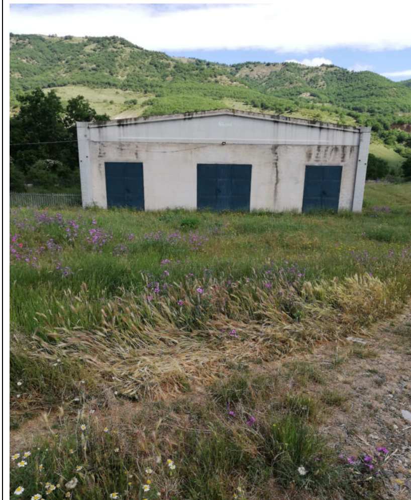
FOTO 3 - INT. 2.1.1__LOC. Zona PIP (Macello Regionale)
