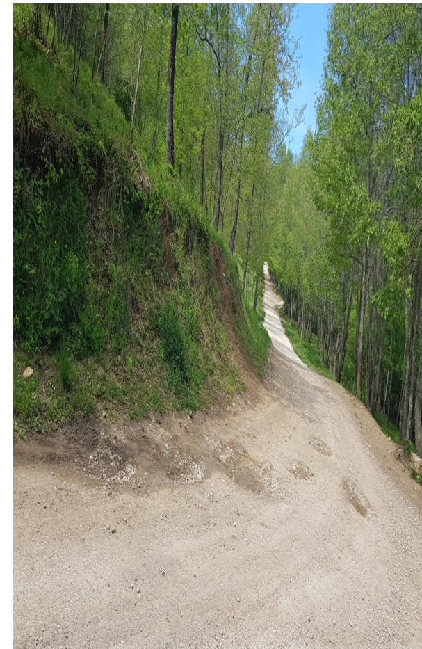
Manutenzione pista forestale – Loc. Nocellaro I.03.008.01
