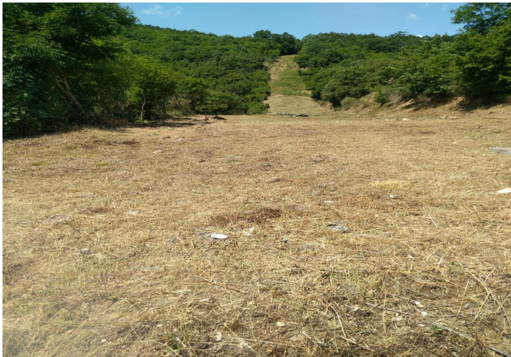
Int. Manutenzione viale tagliafuoco Loc. Pietrapica Fg 51 P.Ila 839 coord 40.06548 N 16.22313 E
