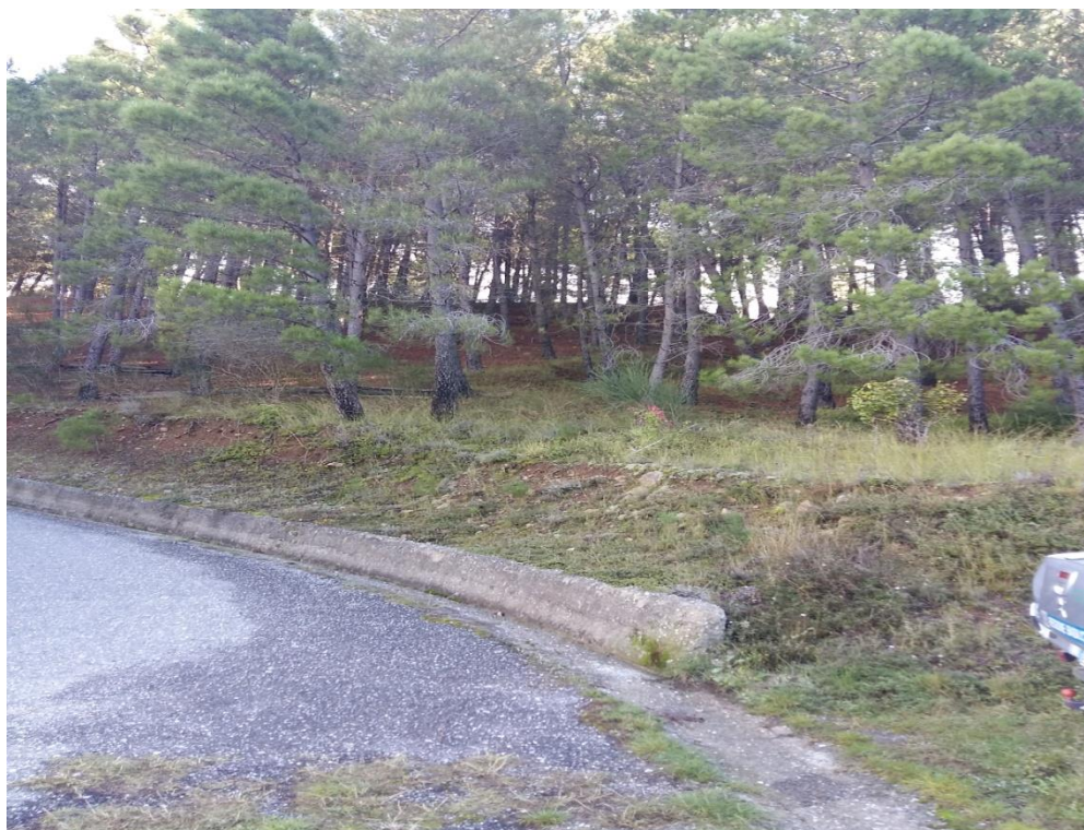
Int. Manutenzione viale tagliafuoco Loc. Banchetti Fg.26 P.IIa 1 coord. 40.05085N 16.200876 E
