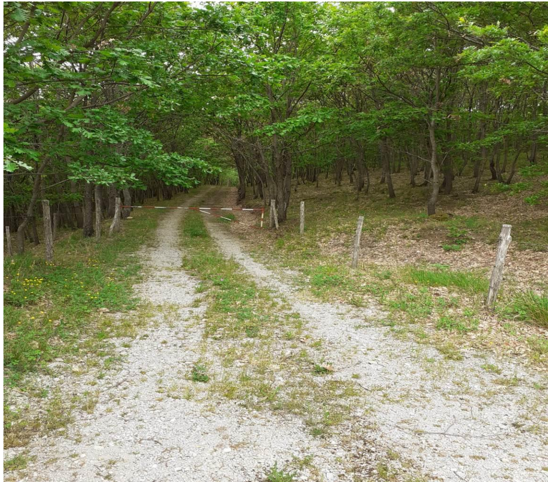
INTERVENTO 1.1.1 MANUTENZIONE FASCE
