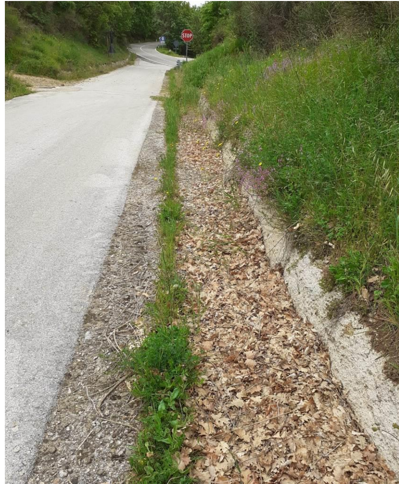
INTERVENTO 5.1.1 PULIZIA CUNETTE A
