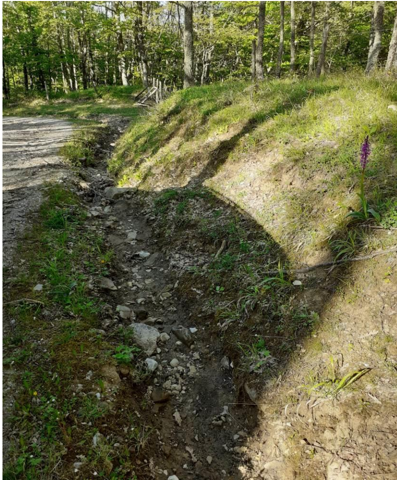
INTERVENTO 5.1.1 PULIZIE CUNETTE
