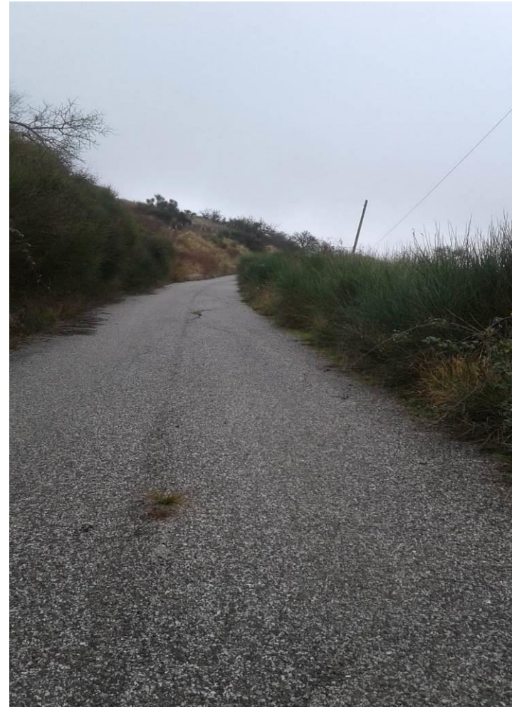
Intervento 5.1.1 MANUTENZIONE STRADA
