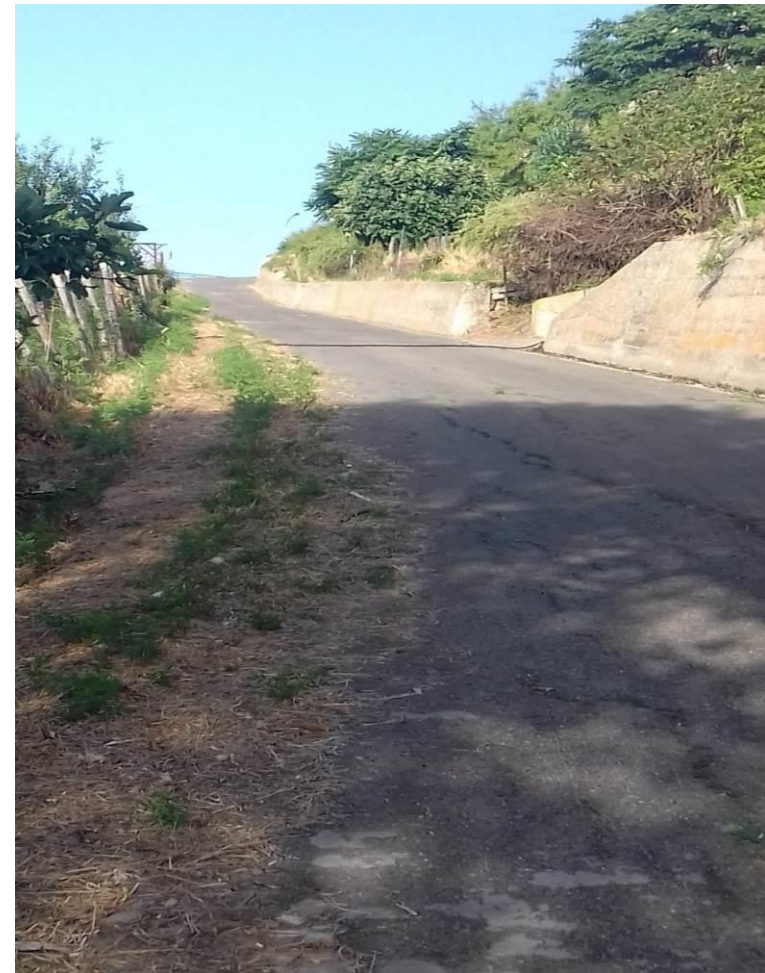
Intervento 5.1.1 MANUTENZIONE STRADE MONTEMURRO
