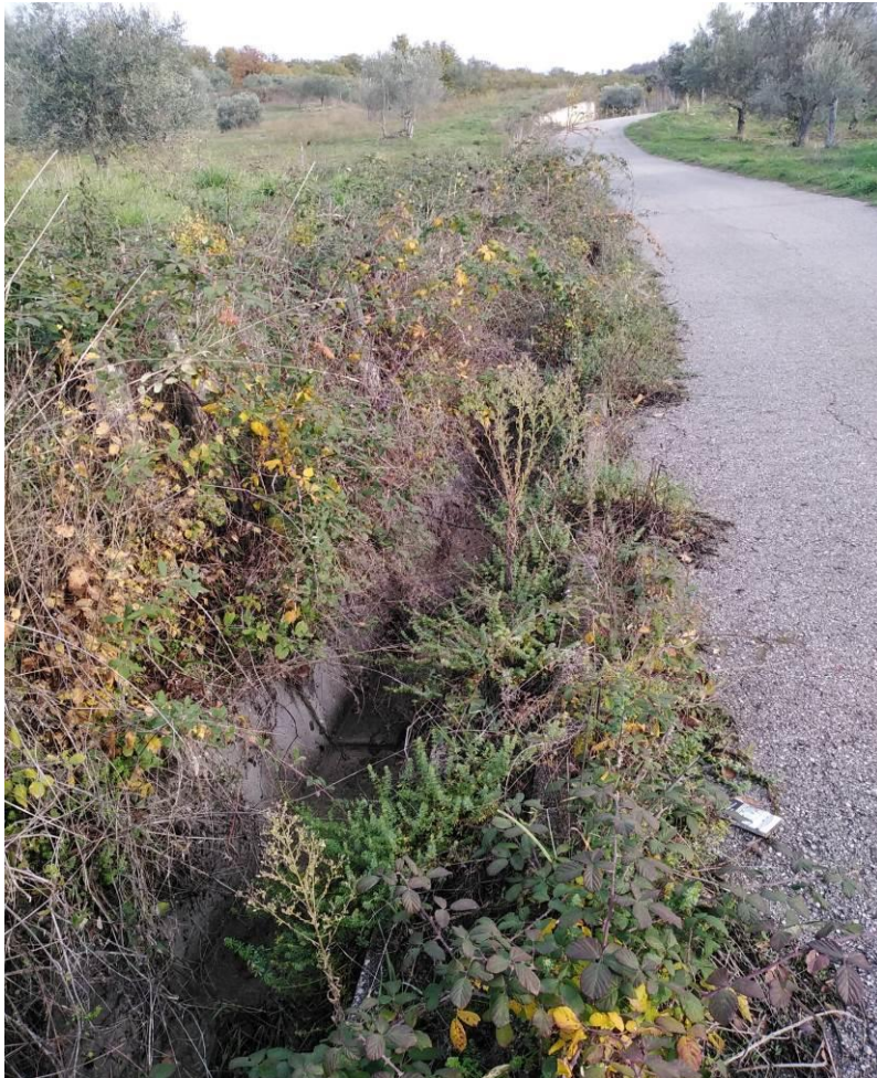
Intervento 5.1.1 PULIZIE CUNETTE MONTEMURRO
