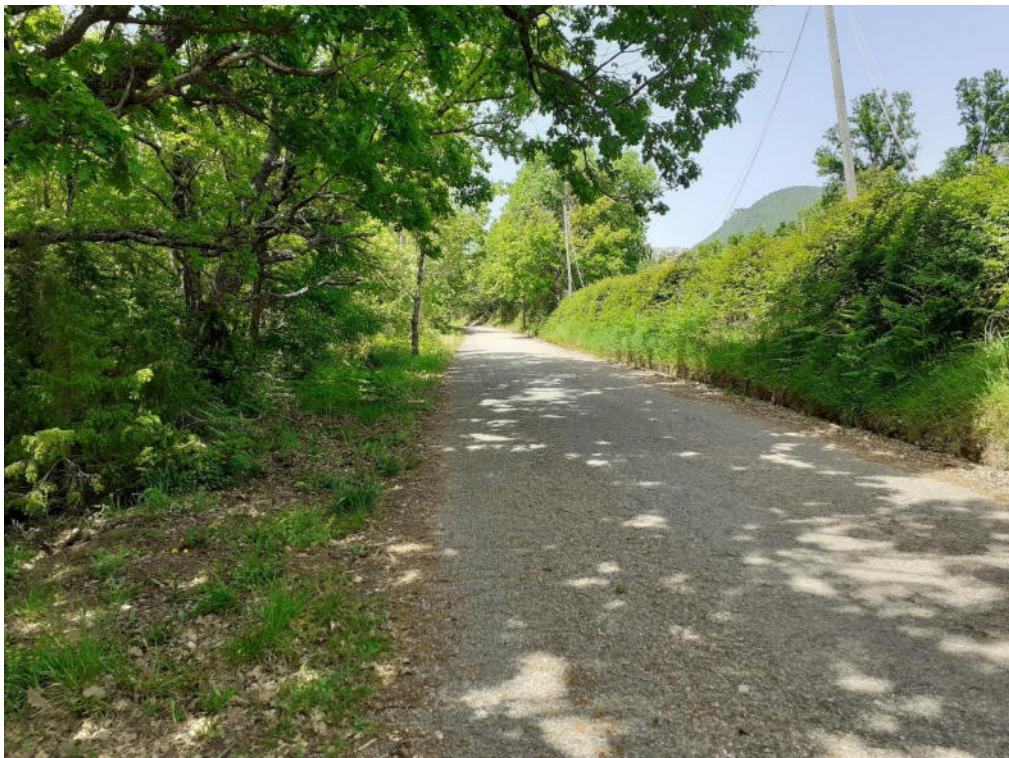
Int. 1.1.5 Loc. Strada San Evraso
