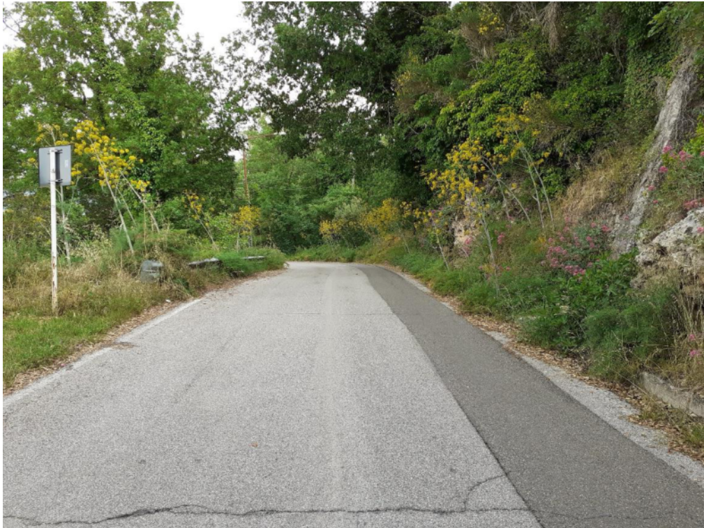
Int. 5.1.2 Loc. Strada Calda 2° tratto
