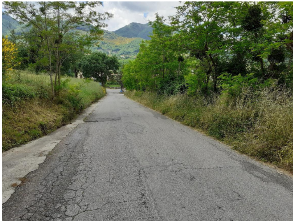
Int. 5.1.4 Loc. Strada San Lorenzo-Pedarreto 1°tratto NORD: 39°56'19.86'' EST: E 16°2'49.65''
