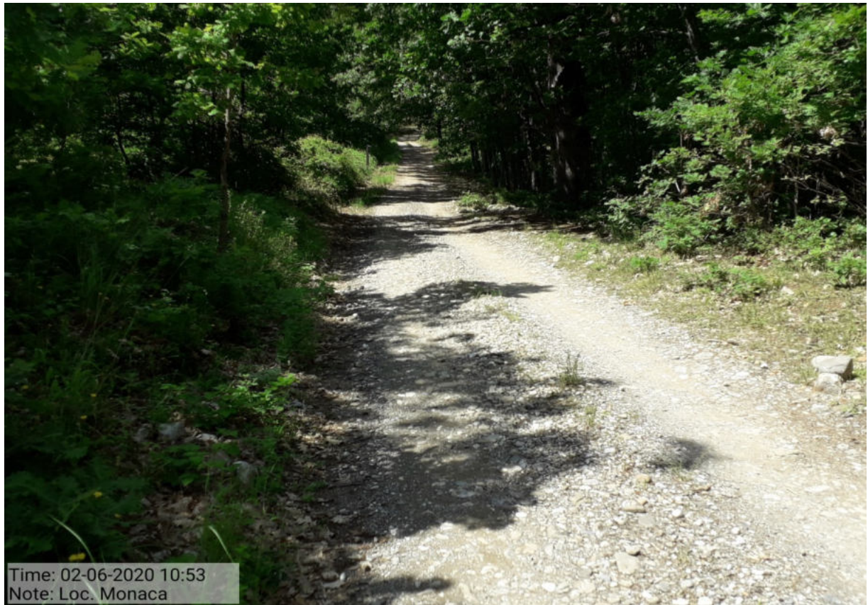
Int. _1.2.2_ Manutenzione Piste. Loc. Calorio –Monaca.
