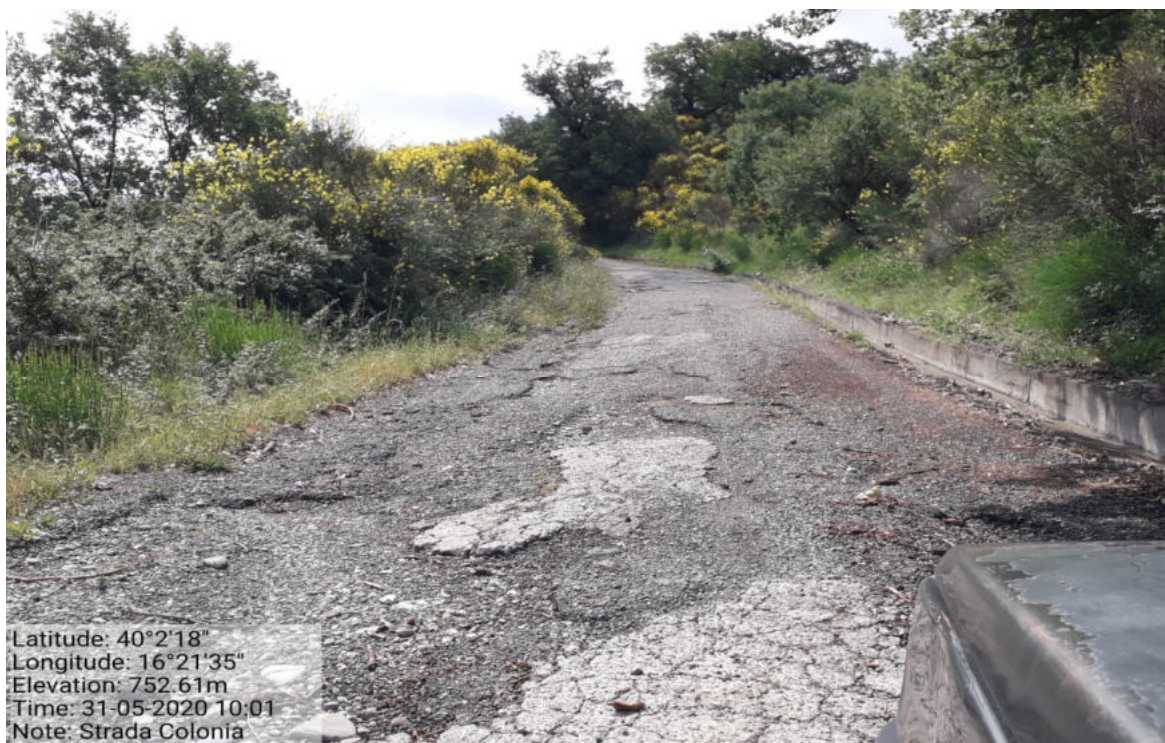
Int. 5.1.1 - 5.2.1 -Pulizia Strade Comunali SS. 482 Loc. Colonia.
