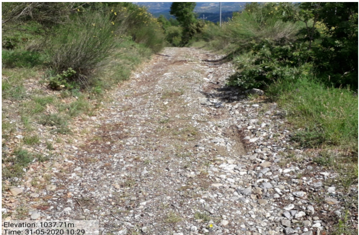
Int. _3.4.1_ Manutenzione Piste Forestali Loc. Monaca.
