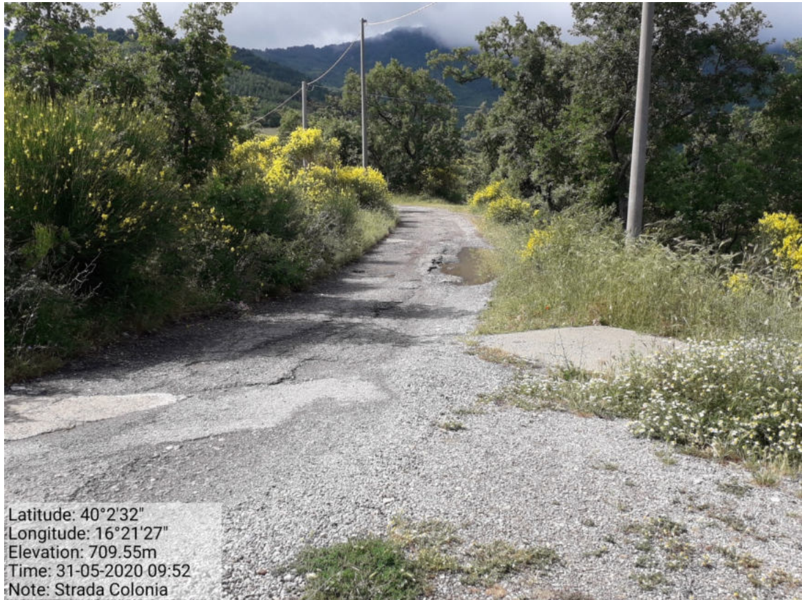
Int. 5.1.1 -Pulizia Strade Comunali SS. 482 Loc. Colonia.
