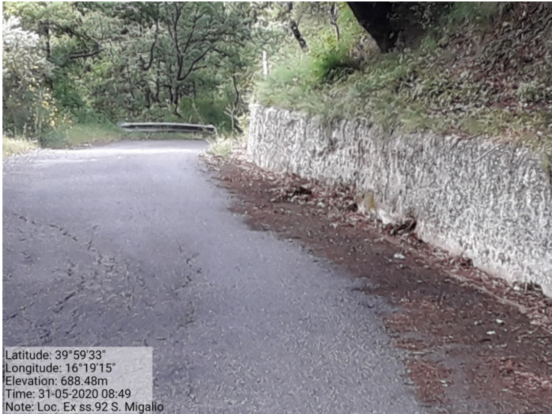
Int. 5.1.3 Pulizia Cunette Strada Comunale Ex. SS. 92 Loc. San Migalio.
