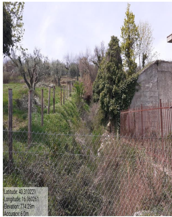
missione 6.1.3.2 canale Lavinaro
