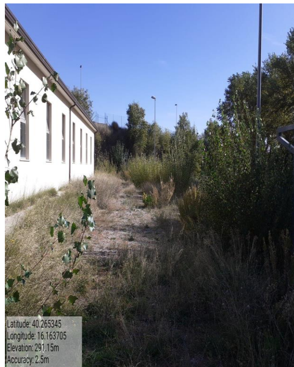
missione 6.1.6.1 autosollelamento Piano Argenzio
