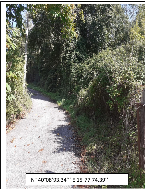
Int. 6.3 – Foto 1 – strada comunale Coste
