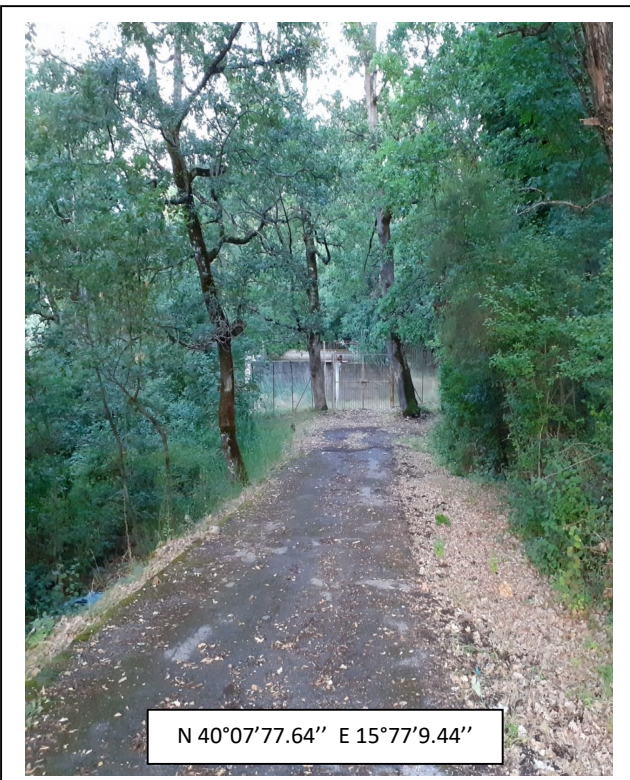
Int.6.1 - Foto 1 – vasca di accumulo Mascalcia
