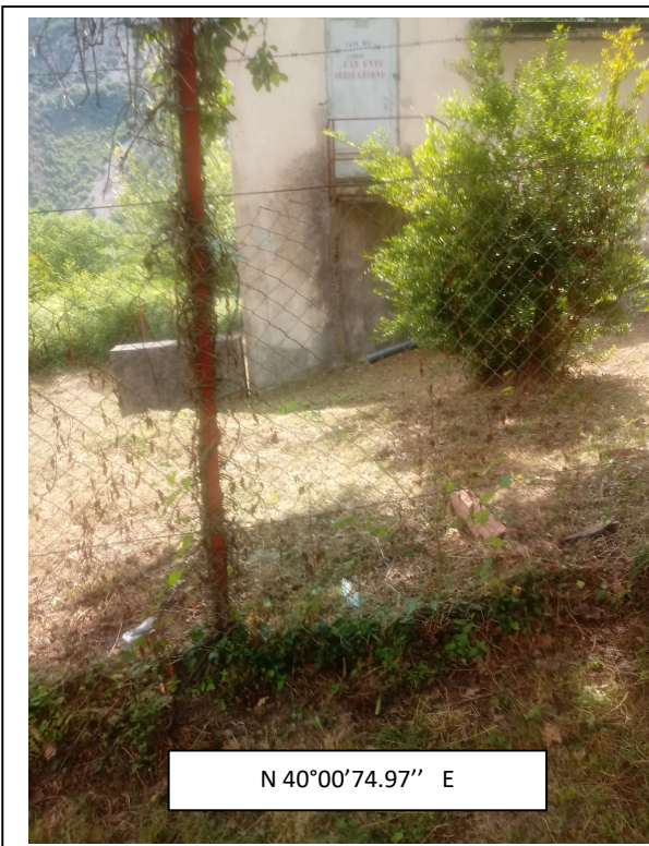
Int. 6.1.1 – Foto 1 – impianto di soll. nto Parrutta
