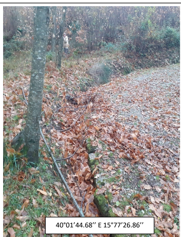
Int.6.3 – Foto 1 - strada monte Santa Maria
