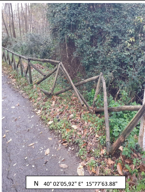
Int.6.4 – Foto 1 - ripristino staccionata Forraina
