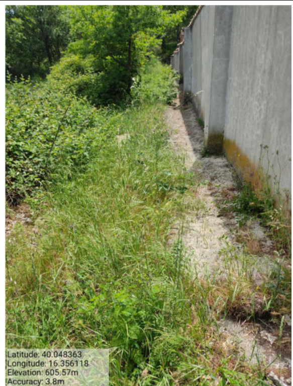
Int. _1.1.4_ Fascie Loc. Cimitero - Foto 1
