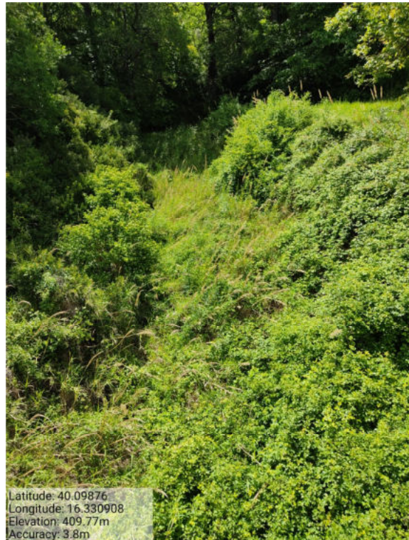
Int. _6.1.3_ Pulizia Fosso Manche Foto Foto 1
