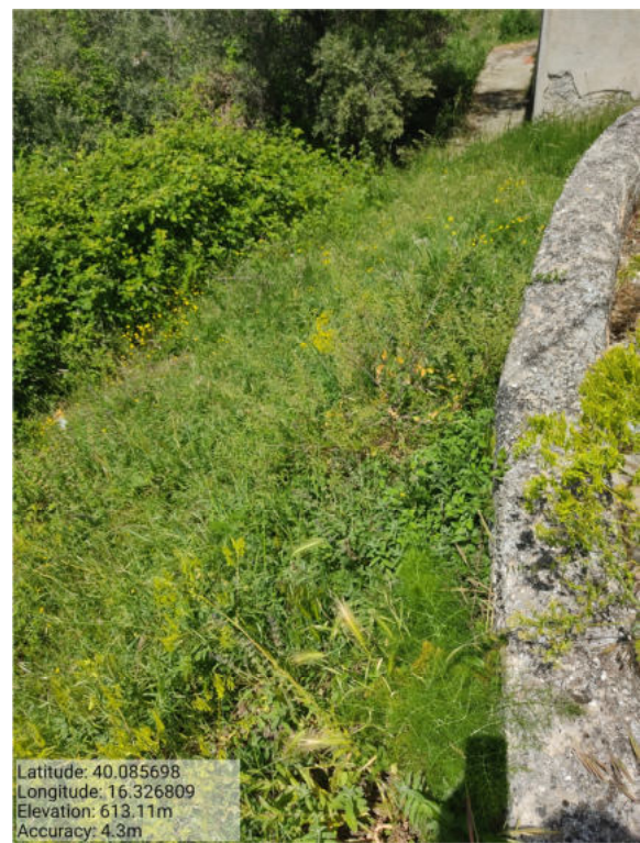
Int. _1.1.5_ Fascie Loc. Manche - Foto 1
