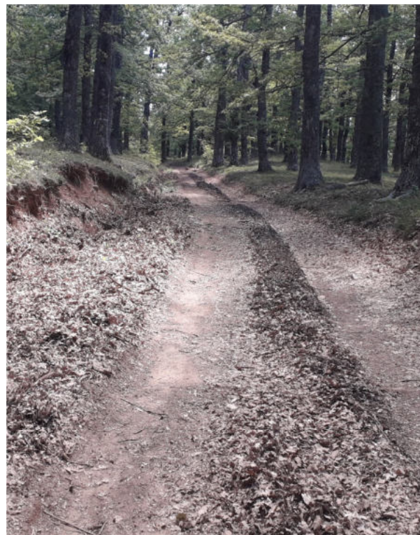
Int. _1.2_ Manutenzione Piste Foto 2
