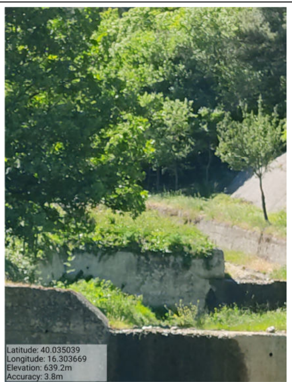
Int. _6.1.2_ Pulizia Fosso Soave Foto 2
