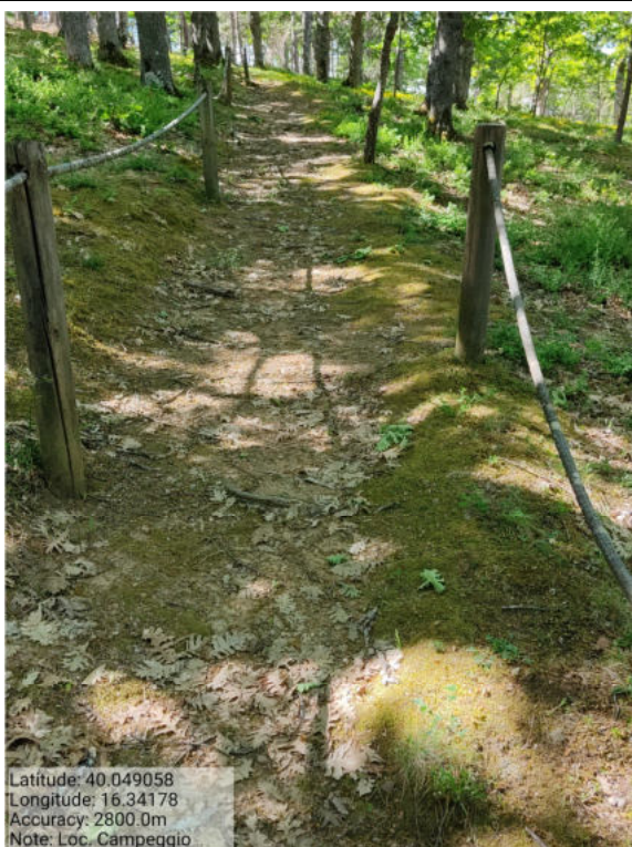
Int. _4.3._ Manutenzione Piste Foto 4
