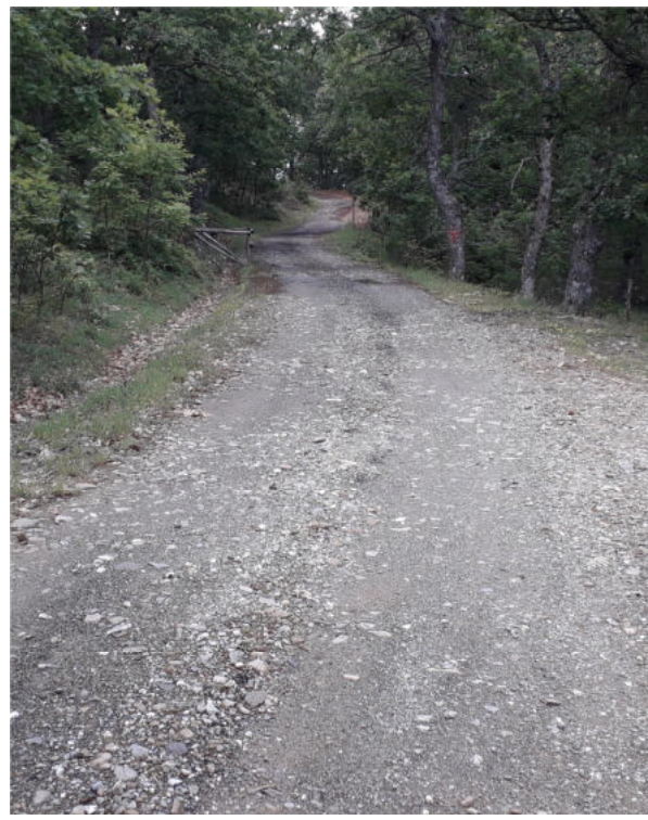
Int. _1.2.1_ Manutenzione Piste Foto 2
