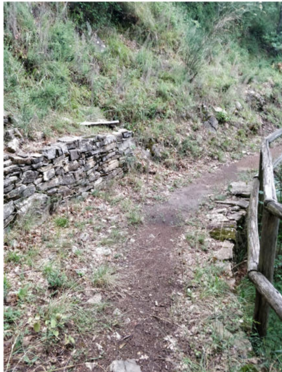
4.2.1_ Manutenzione Sentiero Didattico Foto 4
