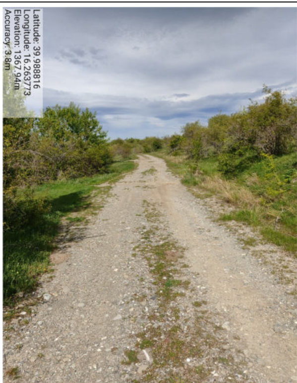
Int. _4.1.1_ Manutenzione Piste Loc. Murgie
