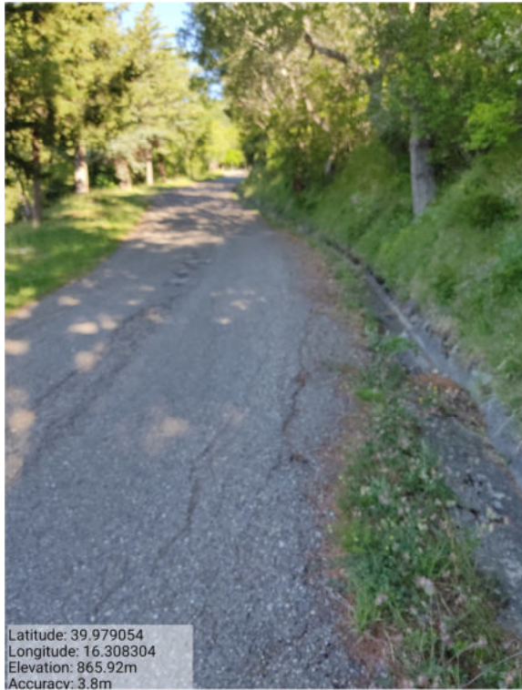
Int. _6.3_Manutenzione Strade Loc. Pietà Foto 1
