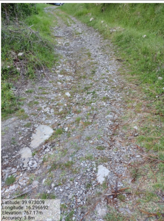
Int. _1.3.1_ Manutenzione Piste Foto 1
