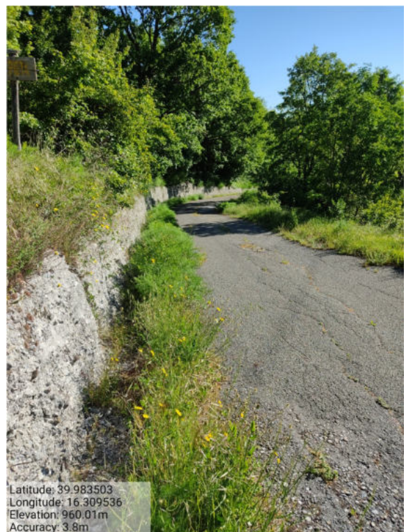
Int. _6.3_Manuten. Strade Loc. Pietà Foto 4
