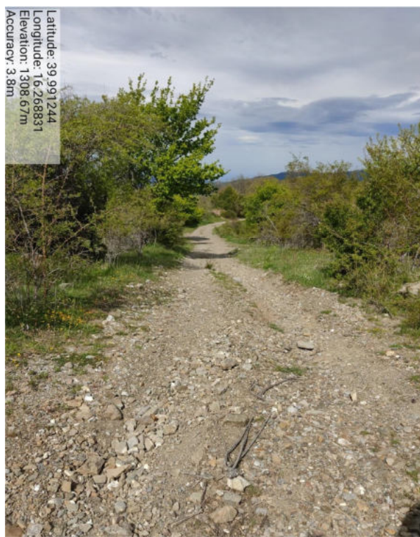
Int. _4.1.1_ Manutenzione Piste Loc. Murgie
