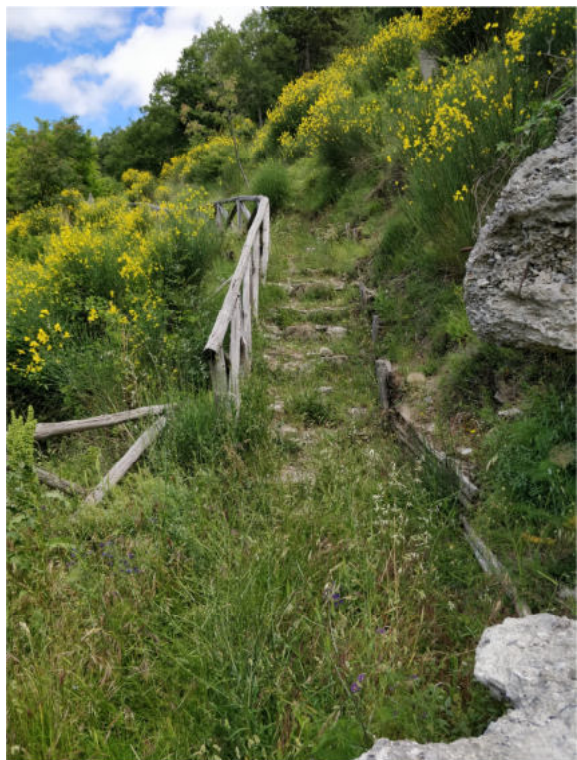
4.2.1_ Manutenzione Sentiero Didattico Foto 3
