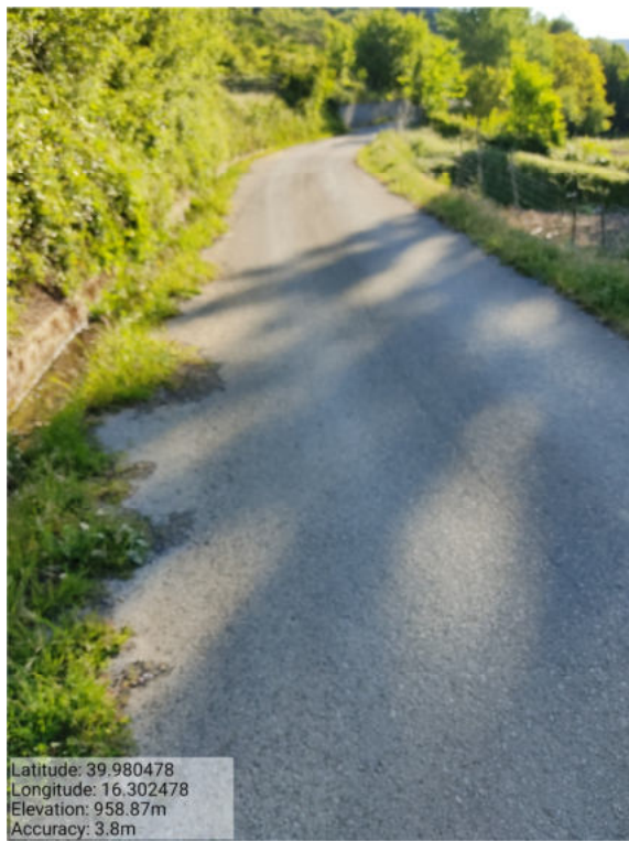
Int. _6.3_Manutenzione Strade Loc. Pietà Foto 3
