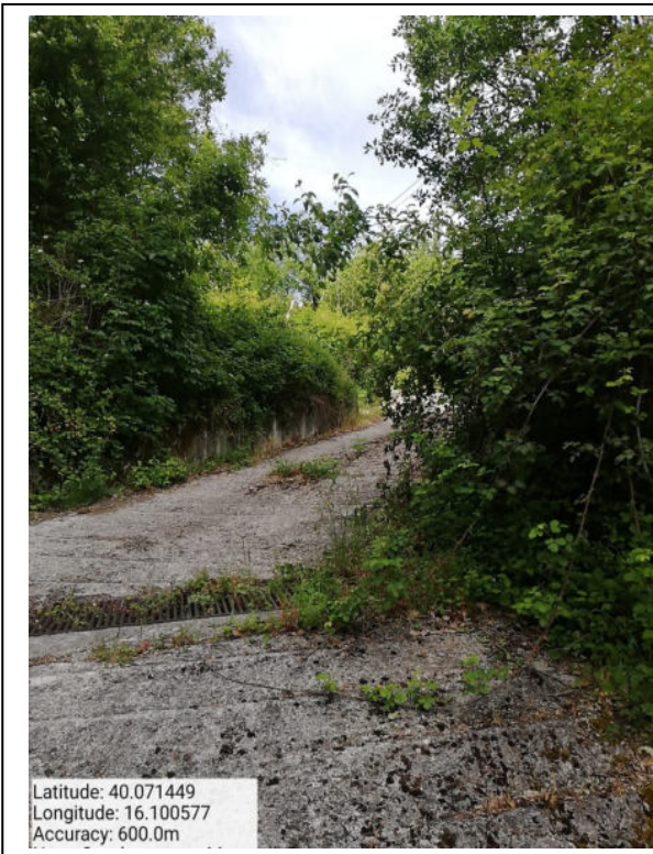
Int. 6.3.11 – Strada per Manca di Sopra - Foto 1
