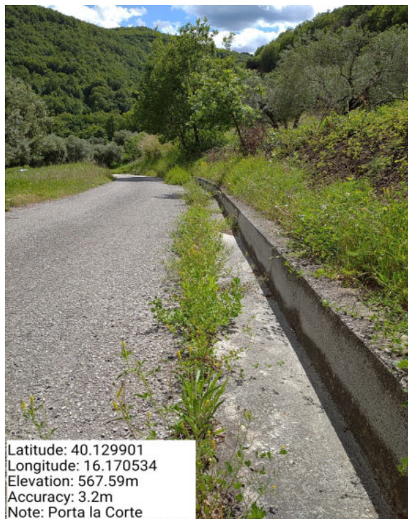
Int. 6.3.7 – Strada Porta la Corte – Foto 1
