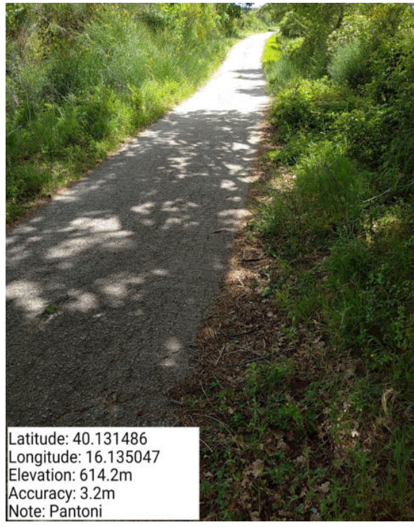
Int. 6.3.4 – Strada Pantoni – Foto 1
