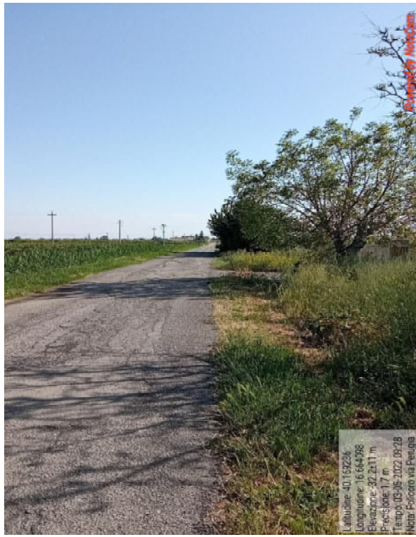
Int.6.3.16.2 Via Perugia Pulizia cunette
