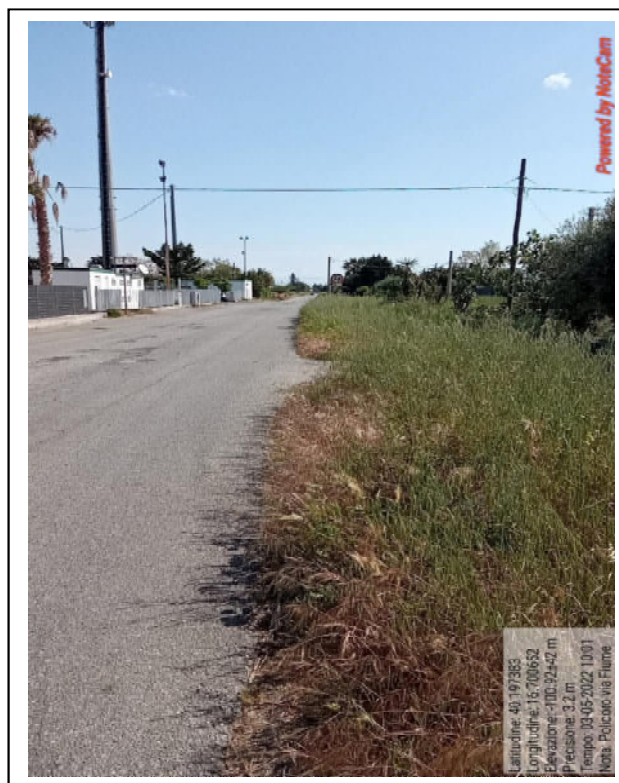
In. 6.3.11.2 Via Fiume Pulizia cunette
