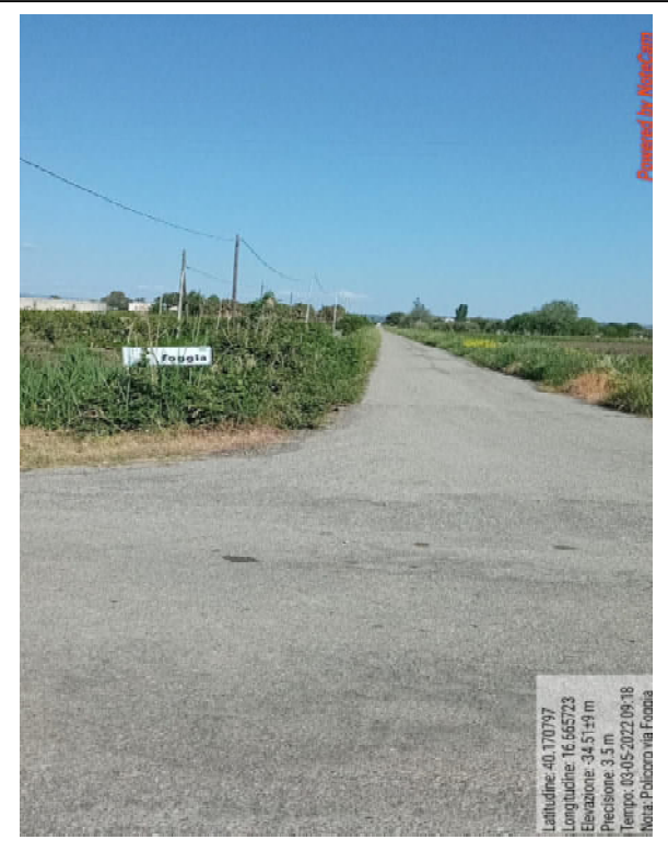
Int.6.3.18.2 Via Foggia Pulizia cunette
