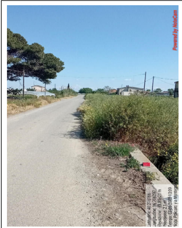
Int.6.3.13.1 Via Montegrappa Decesp. scarpate stradali
