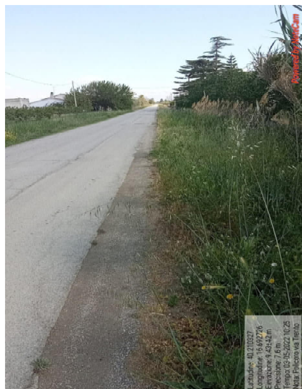
Int.6.3.8.2 Via Trento Pulizia cunette
