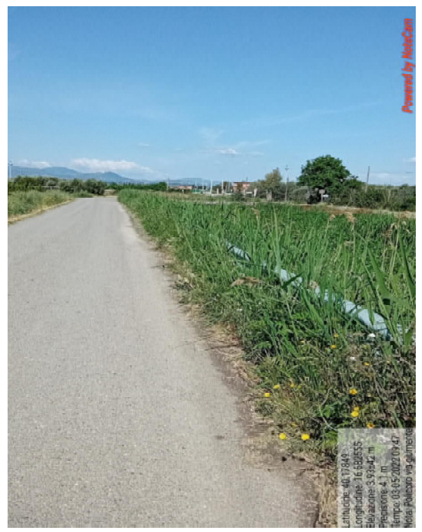
Int.6.3.17.2 Via Giumenteria Pulizia cunette
