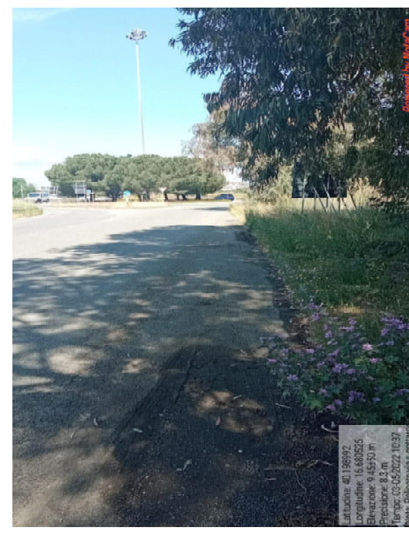
Int.6.3.6.2 Via San Gottardo Pulizia cunette
