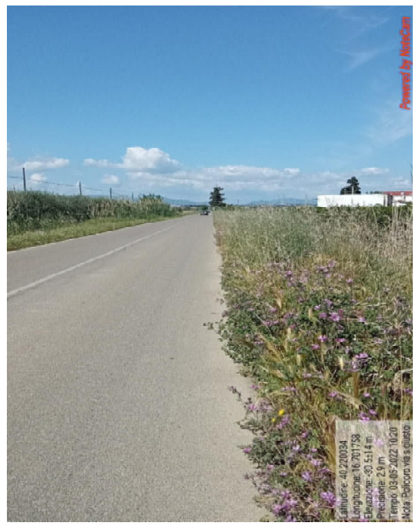
Int.6.3.5.2 Via San Giusto Pulizia cunette
