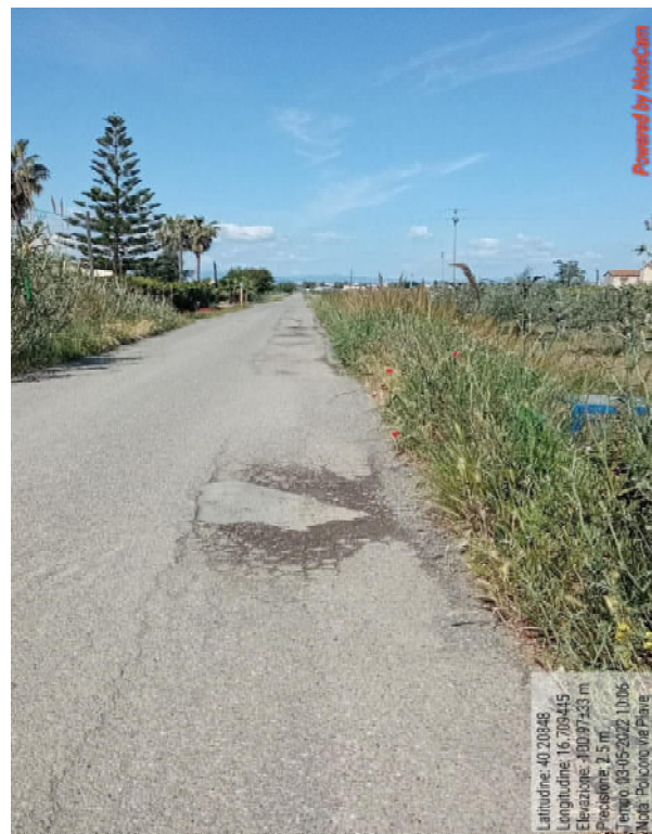
Int.6.3.12.2 Via Piave Pulizia cunette
