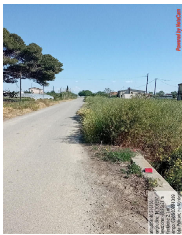
Int.6.3.13.2 Via Montegrappa Pulizia cunette
