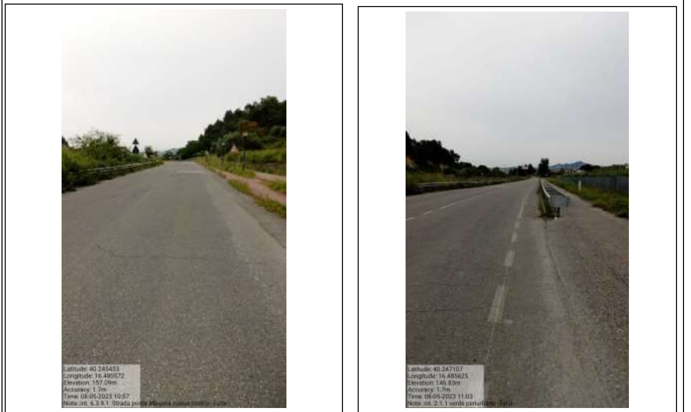
Int. 6.3.9.1 S.P. Tursi ponte masone nuovo tronco
