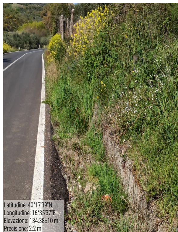
Int.6.3.2.2 S.P. 154 Montalbano J.co - Andriace Pulizia di cunette
