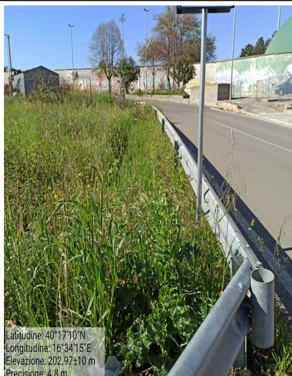
Int.6.3.2.3 S.P. Fratta Montalbano J.co – S.S.598 Pulizia di cunette
