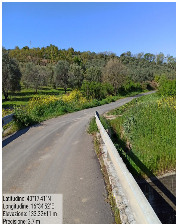
Int.6.3.4.1 Strada Comunale Fosso Valle Decespugliamento scarpate stradali
