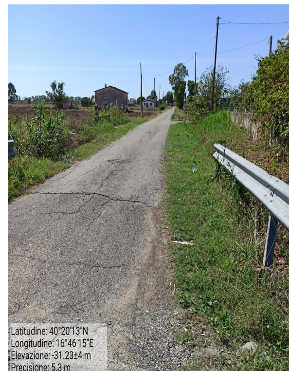
Int.6.3.7 Strada c.da Casinello Decesp. scarpate stradali e pulizia cunette
