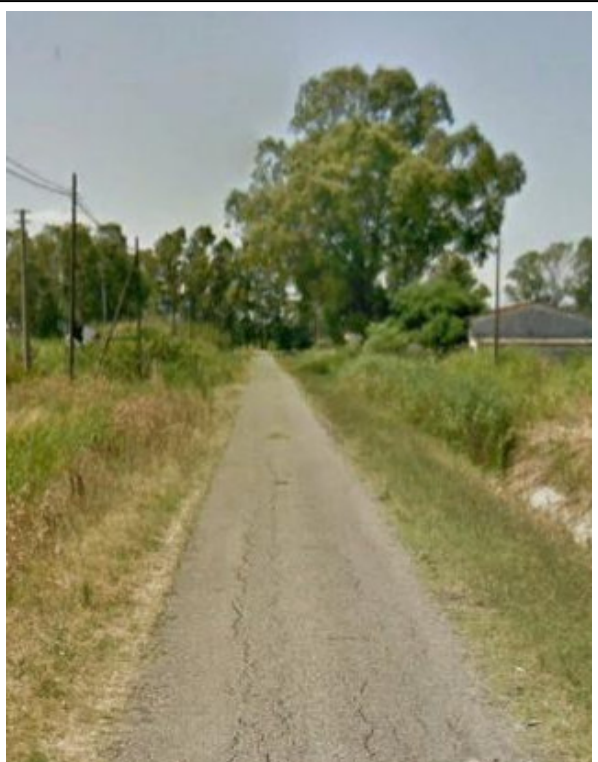
Int. 6.3.8 Via Ulisse Decesp. scarpate stradali e pulizia cunette
