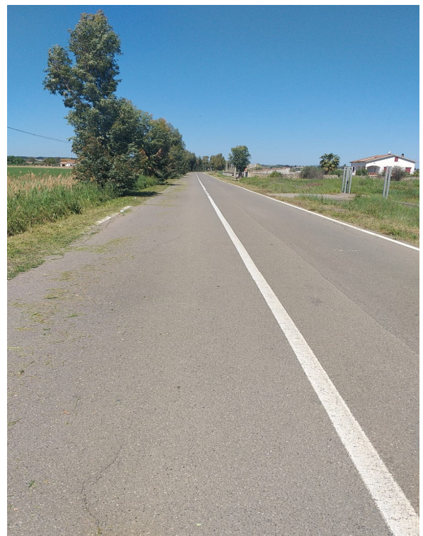
Int. 6.3.6 Via Eracle Decesp. scarpate stradali e pulizia cunette
