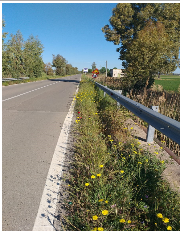
Int. 6.3.3 Strada S. Teodoro viale 48 Decesp. scarpate stradali e pulizia cunette
