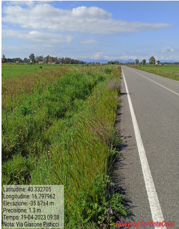
Int.6.3.5 Via Giasone Decesp. scarpate stradali e pulizia cunette
