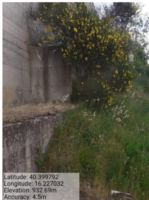
INT. 2.1.1 CENTRO ABITATO
