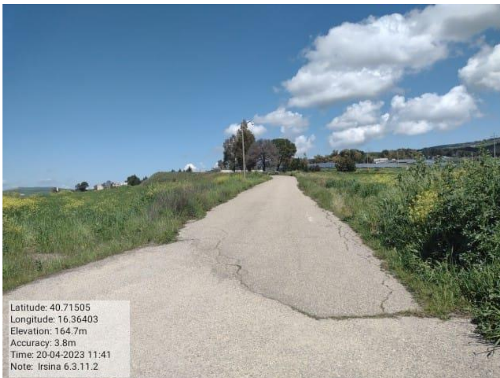
Int. - 6.3.11.2 Irsina Fg.66 Strada Comunale S.M. d'Irsi 1 Foto N.58
