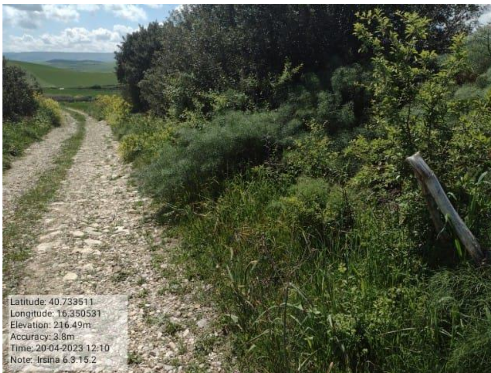
Int. - 6.3.15.2 Irsina Fg.49 part.68 strada Consortile S. Maria d'Irsi Foto N.66
