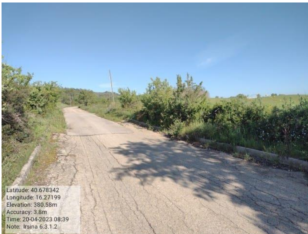
Int. 6.3.1.2 Irsina Fg.74 STRADA COMUNALE PER VERRUTOLI
