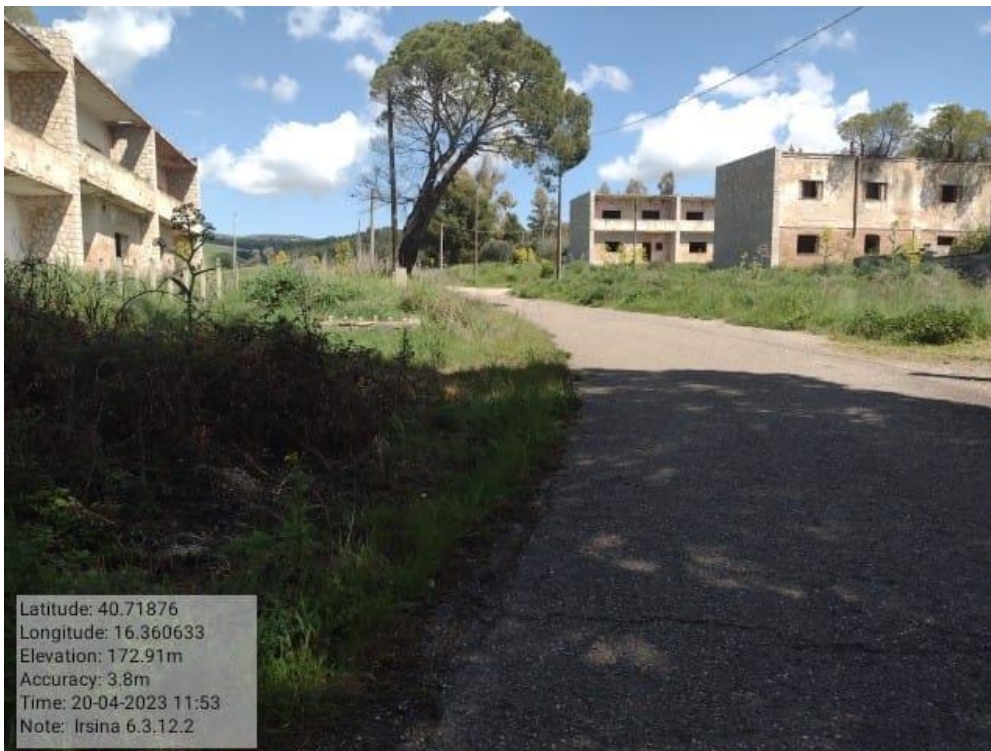
Int. - 6.3.12.2 Irsina Fg.66 Strada Comunale S.M. d'Irsi 2 Foto N.60
