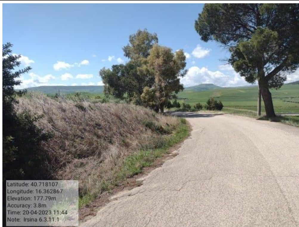
Int. - 6.3.11.1 Irsina Fg.66 Strada Comunale S.M. d'Irsi 1 Foto N.57
