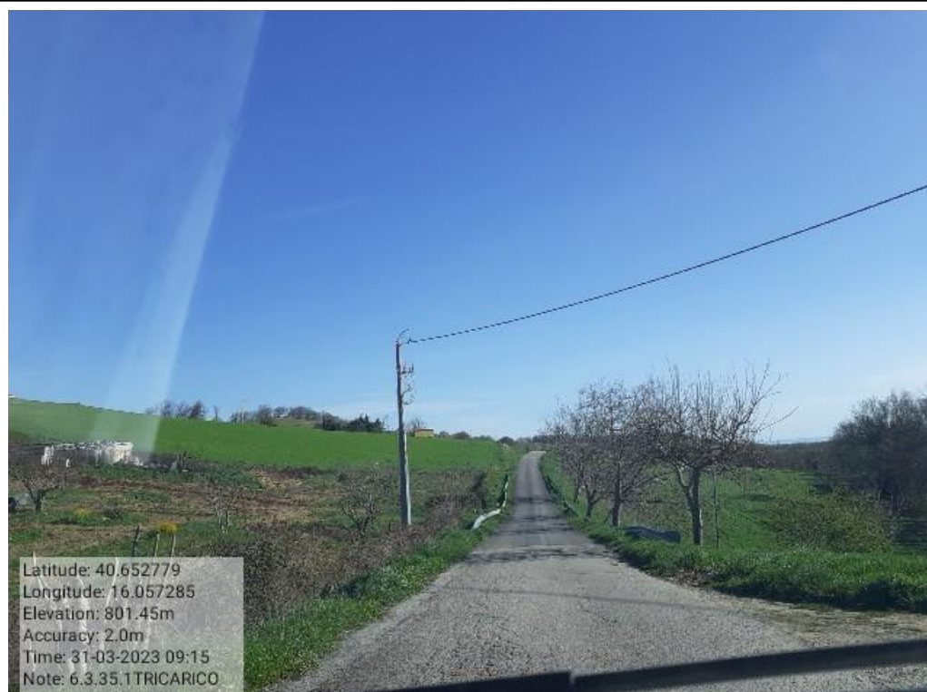
INTERVENTO 6.3.35 - TRICARICO STRADA COMUNALE TRIONTE FG19-19-20-31-32-42 Foto n.75
