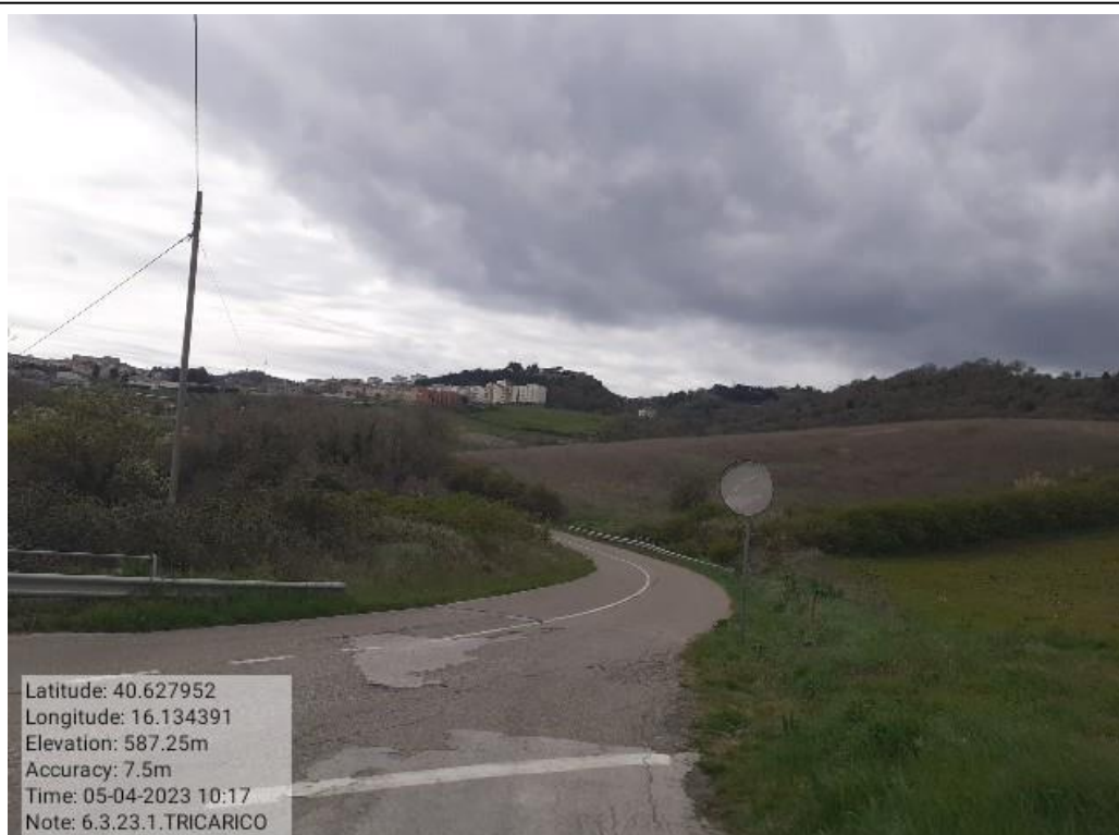
INTERVENTO 6.3.23 - TRICARICO STRADA PROVINCIALE BOCCANERA FG.46-47-35-36-21 1° TRATTO Foto n.63
