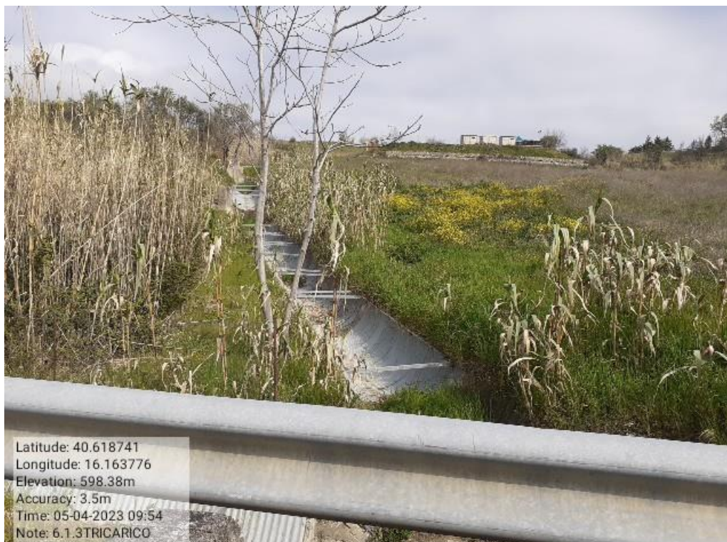
INTERVENTO 6.1.3 - TRICARICO Fg.66 part.97-574-39 CANALE PIANO DELLE GINESTRE Foto n. 31
