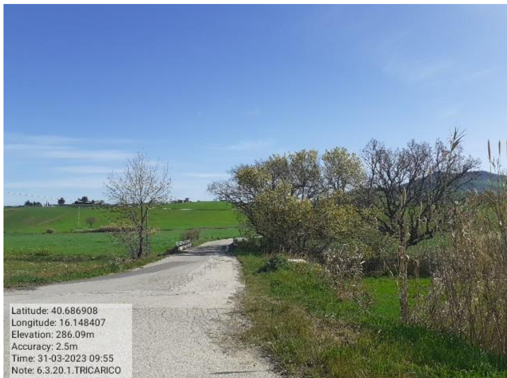
INTERVENTO 6.3.20.- TRICARICO T Fg 15-14-6-10 Strada Comunale Serramendola Bassa Foto n. 60
