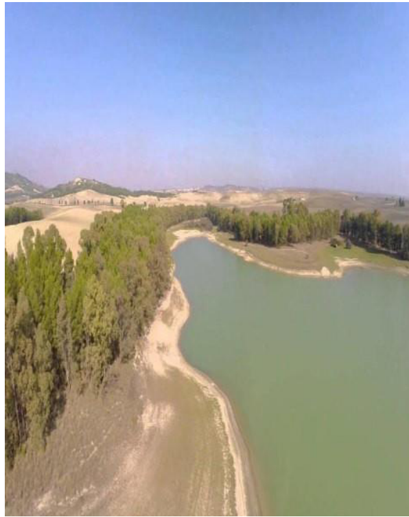
Int. 4.2.1. MATERA – DIGA SAN GIULIANO – MANUTENZIONE PISTA FORESTALE N: 40°36'23.62"; E: 16°32'17.35"
