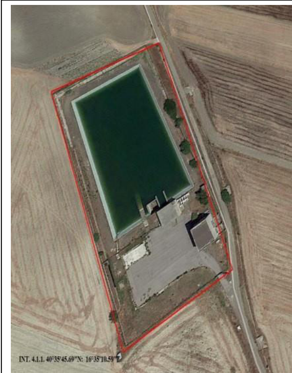
INT.6.1.1. DECSPUGLIAMENTO VASCA DI ACCUMULO
