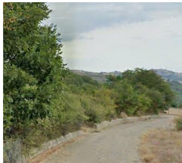
Int. 6.3.7.1+6.3.7.2 - Strada Cugni-Farneta foto n°2
