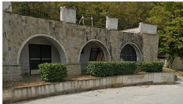
Int. 2.1.11- Area parcheggi- valle piste da sci Pierfaone e area turistica Foto n°2
