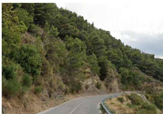
Int. 6.3.1.1+6.3.1.2 - S.P.5 Ponte Giardino-Sellata- Pignola- foto n°2
