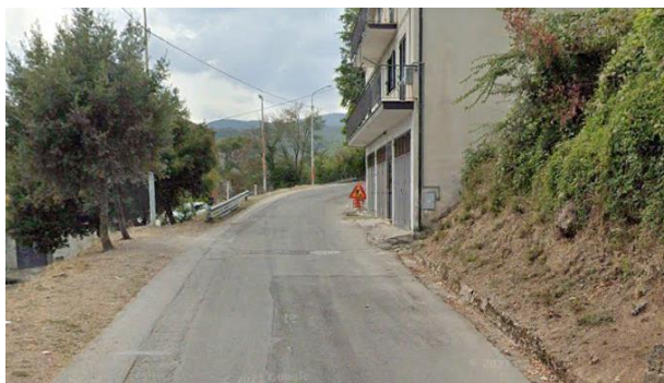
Int. 2.1.1 – Centro abitato di Abriola Foto n° 1
