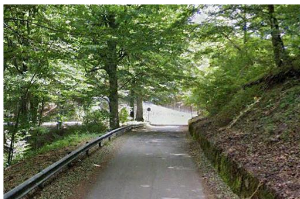
Int.6.3.1.1+6.3.1.2-S.P.5 Ponte Giardino-Sellata- Pignola- foto n°1
