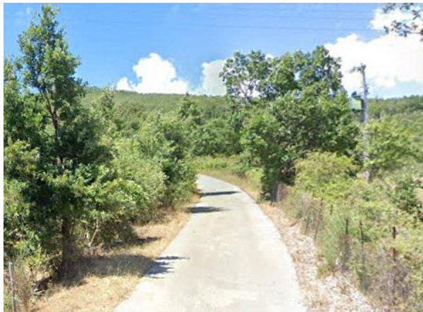
Int.6.3.10.1+6.3.10.2-Strada Cerrachiere foto n°1
