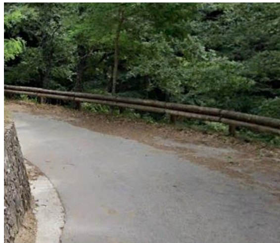
Int.1.1.2 – Fascia su Strada Sellata-Rifreddo foto n°2
