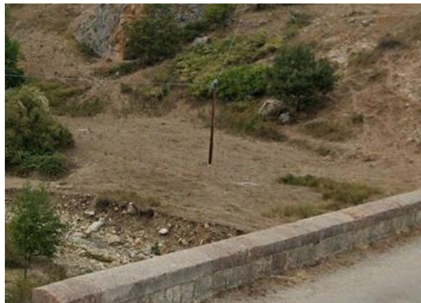
Int.6.1.1-Torrente Fiumicello foto n°1
