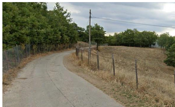
Int. 6.3.10.1+6.3.10.2 -Strada Cerrachiere foto n°2
