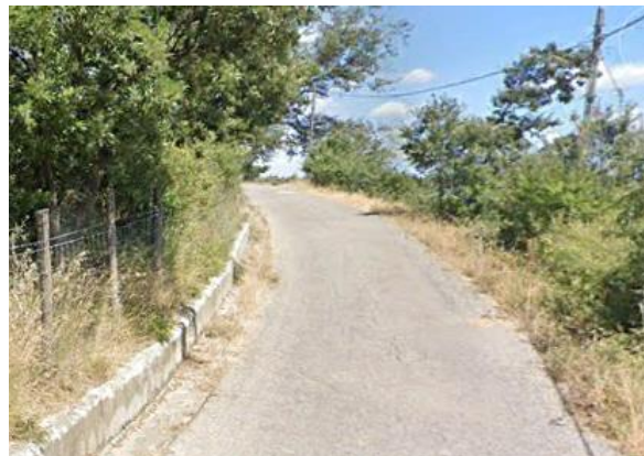
Int. 6.3.8.1+6.3.8.2 - Strada Valloni di sotto foto n°2
