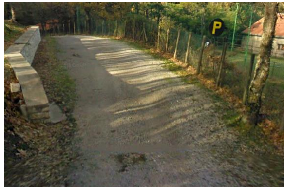
Int. 1.1.1 – Manutenzione viale tagliafuoco su strada forestale Caprara-Gammuzzi Foto n° 2
