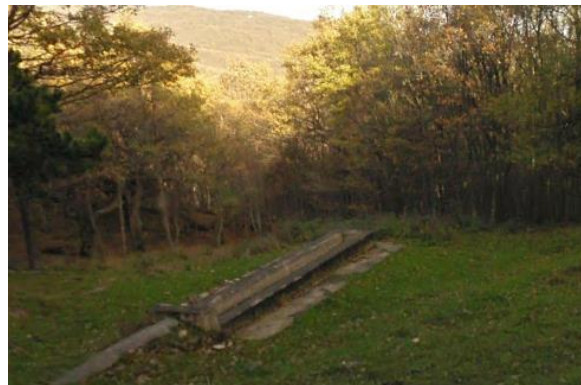
Int. 2.17– Area Caprara foto n°2
