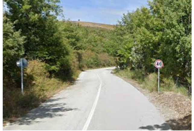
Int. 6.3.8.1+ 6.3.8.2 - Sp.13 tratto Anzi- Abriola foto n°2
