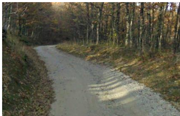
Int. 1.1.1 – Manutenzione viale tagliafuoco su strada forestale Caprara-Gammuzzi Foto n° 1
