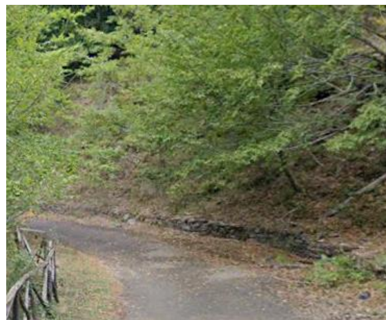
Int. 2.1.4. – Area pic-nic acqua Solfurea Foto n°2
