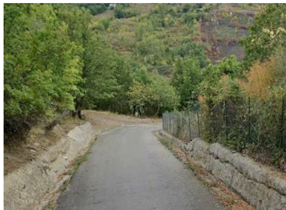
Int. 6.1.10 + 6.2.10 - strada comunale Sorbaro-Isca soprana foto n°1
