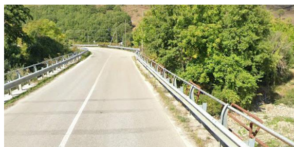
Int. 6.1.2. – Fiumara la terra –tratto extraurbano foto n°2
